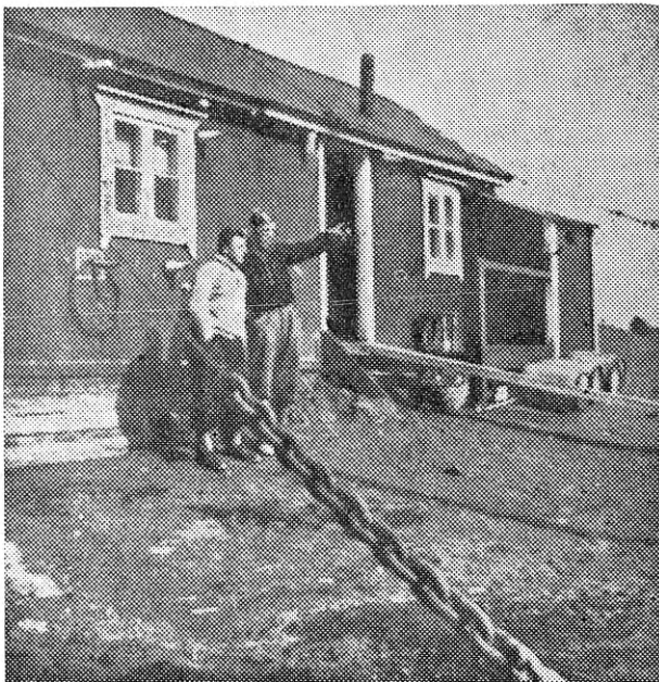
Jan Mayeni ilmajaama-hoone on tugevate kettide ja trosidega „ankrus“, et polaartormid teda ei viiks minema.
