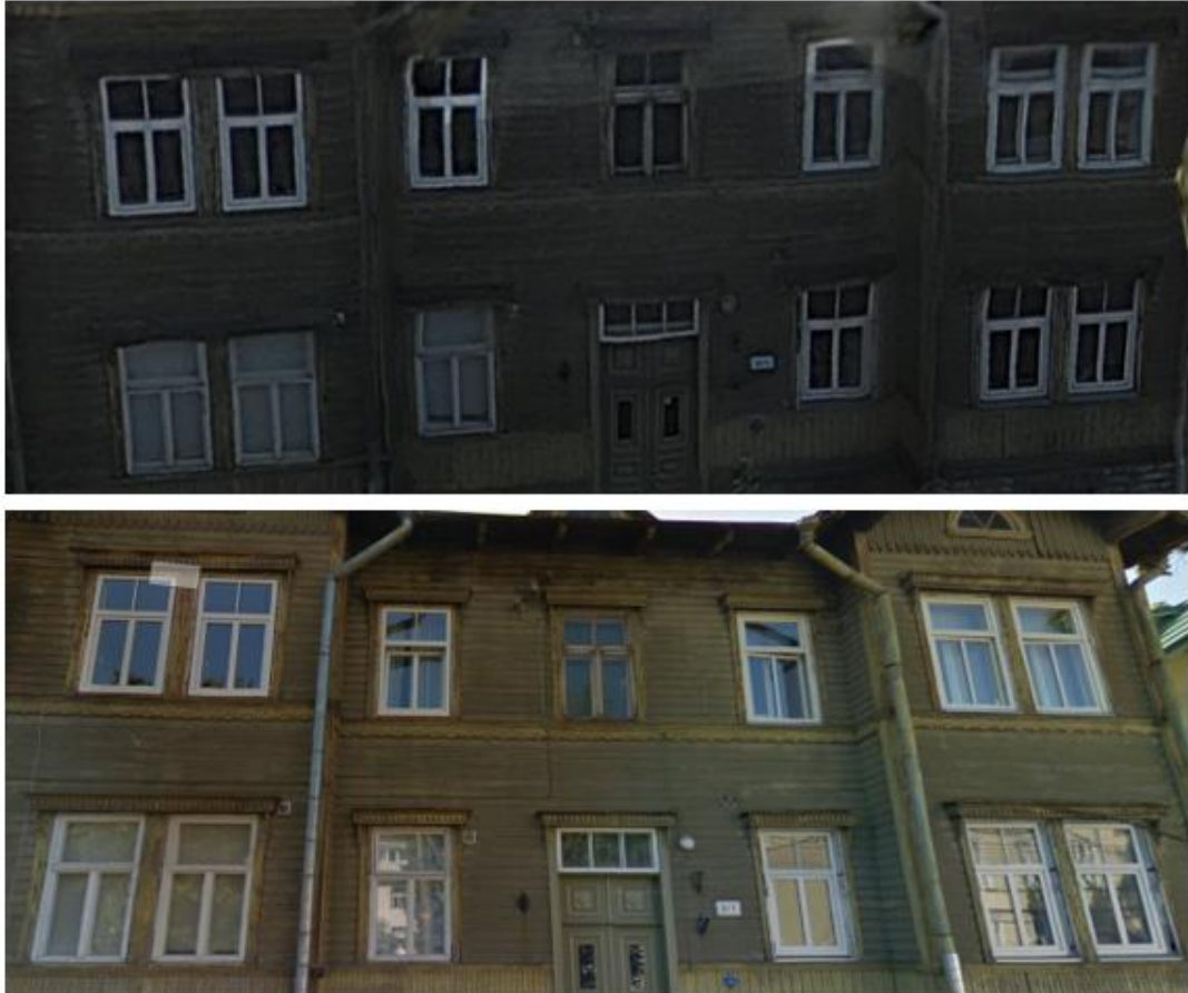
Joonis 4.2 Akende seisukorra hinnangu valideerimine. Üleval – 3D mudel; all – Google Maps Street View foto
