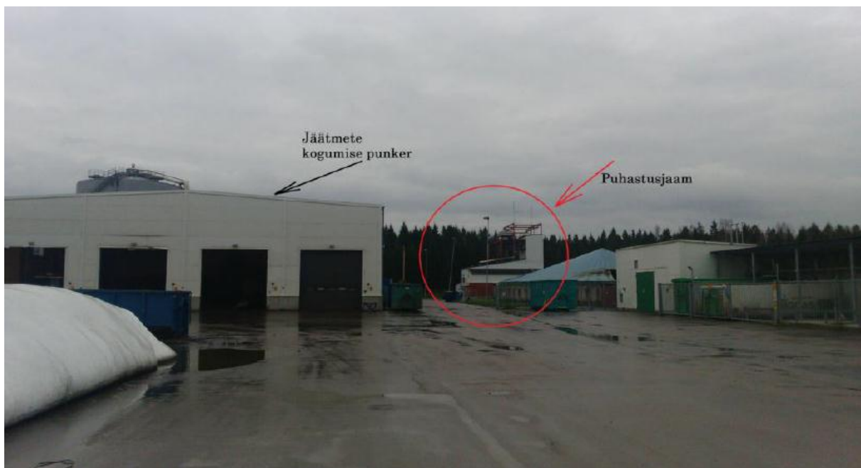
Sele 3.2 Biogaasi tootmise jaam Västerås
