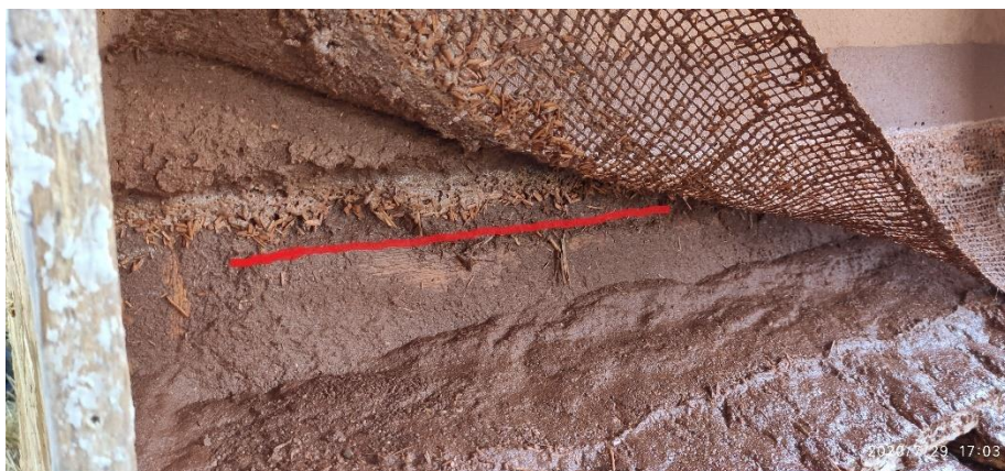
Joonis 47. Fotel on punase joonega näidatud põhu ja alumise puitvöö piir
