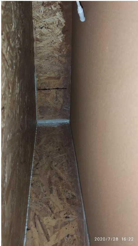
Joonis 40. Siseruum pildistatud läbi vaatlusava. Liitekohtades on näha ka silikooni.
