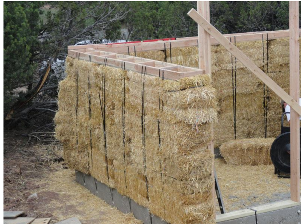
Joonis 15. Kandev seinakonstruktsioon. [3] Joonis 16. Kandev põhusein. Vundamendi sisse on valatud plasttorud, millede kaudu ühendatakse vundamendiga pingutusrihmade abil ülemine müüriplaat. [33]
