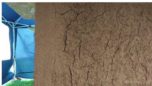
Joonis 35. Nakkekrohv neljandal päeval pärast krohvimist
