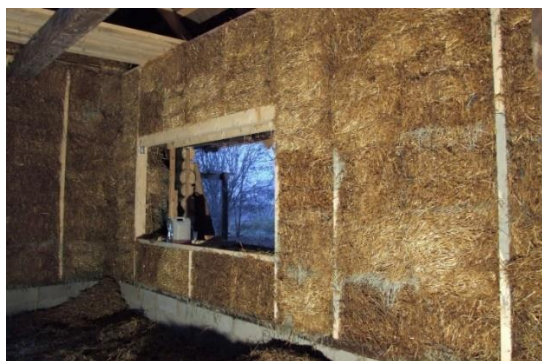
Joonis 18. Karkassipõhine seinakonstruktsioon [35].
