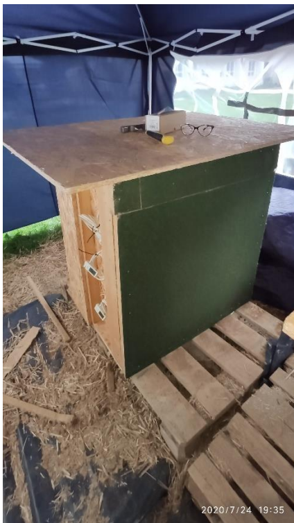
Joonis 38. Katsekehade välimistele külgedele paigaldati tuuletõke
