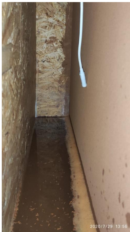
Joonis 42. Siseruumi põhja valatud vesi
