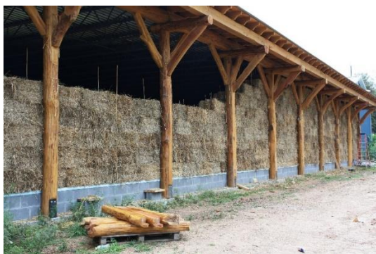
Joonis 17. Karkassipõhine põhust konstruktsioon [34].
