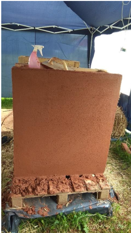
Joonis 36. Värskest peale kantud teine krohvikihit
