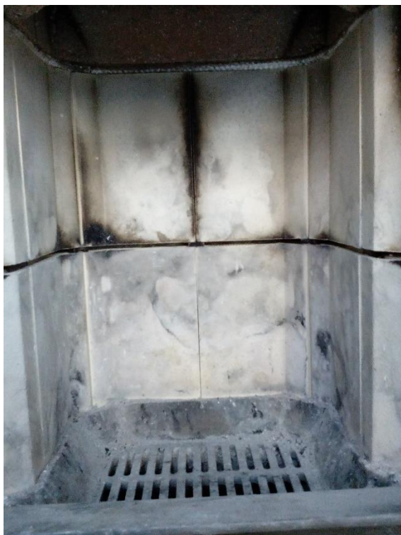
Joonis 11 Peenike õhuvahet põlemiskambri keskel
