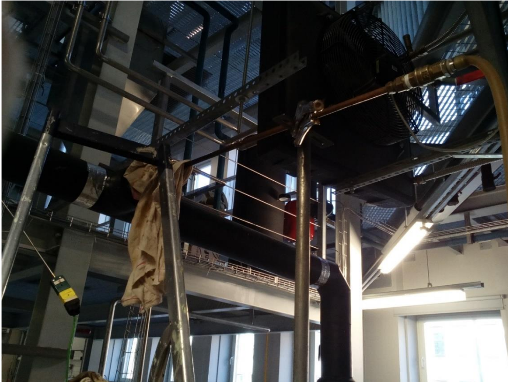
Joonis 2 Ahjust väljuv gaasitoru, millesse on sisestatud separaator koos filtriga
