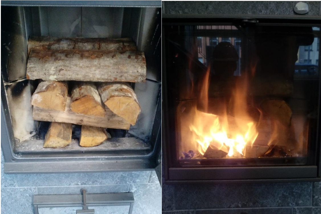
Joonis 8 Alt süütamine paberiga (vasakul) ja tule liikumine esimesel minutil (paremal)
