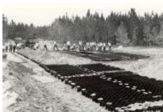
Joonis 1.1 USA Armees Inseneride Korpuse katsetab Geoweb toodet Blandingis 1982.a [3]
