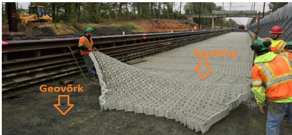
Joonis 7.2 Kombineeritud lahendus geokärje ja geovõrgu kasutamisega [16]
