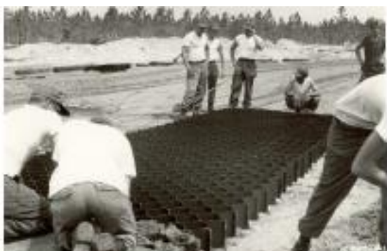
Joonis 1.1 USA Armees Inseneride Korpuse katsetab Geoweb toodet Blandingis 1982.a [3]
