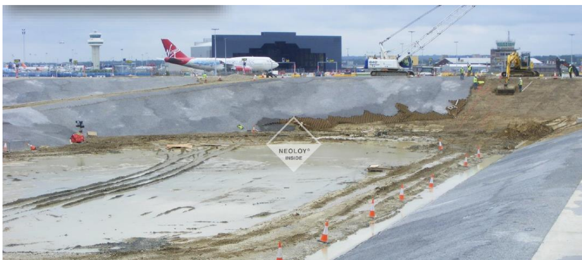
Joonis 2.3 Tormivee reservuaari ehitamine [7]
