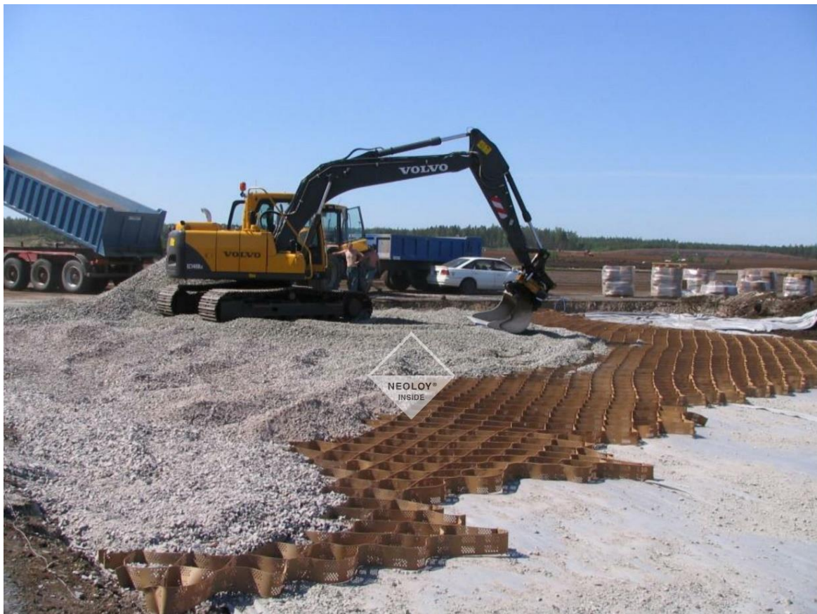
Joonis 2.5 Neoloy Tough Cell geokärje paigaldus turba aluskihile Soomes [9]
