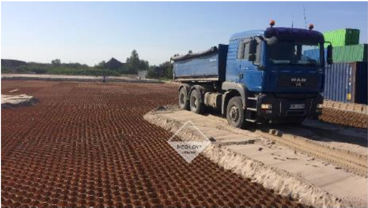
Joonis 2.4 Neoloy Tough Cell geokärje kasutamine konteinerterminali ehitamisel Poolas [8]
