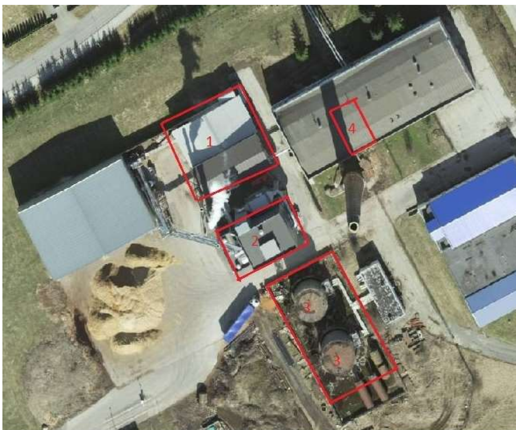
Joonis 1.1. Paide koostootmisjaama hooned. 1 - Wärtsilä katlamaja, 2 - Paide KTJ hoone, 3 - Vanad kütusemahutid, 4 - LNG tipukatel
