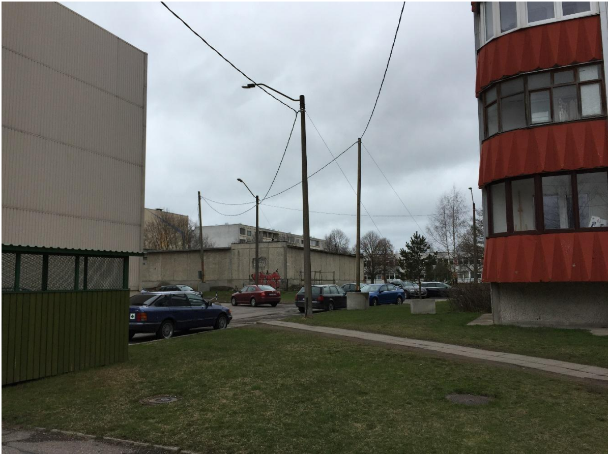
Joonis 5.6 Lõplikult väljaehitatud ajutine liin, kasutades olemasolevaid maste kui ka puitmaste betoonjalanditel.
