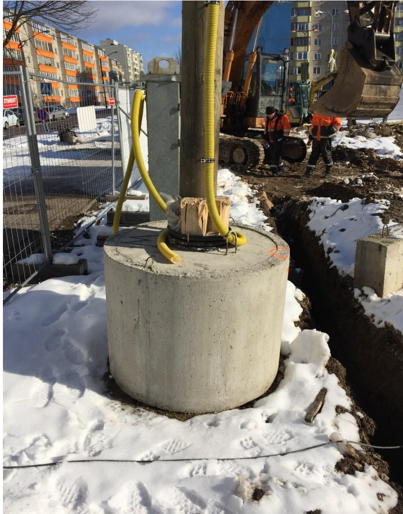
Joonis 2.5. Paigaldatud ajutine puitmast betoonkannul.
