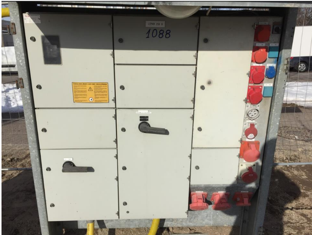
Joonis 5.5. Paigaldatud ajutine töömaakilp.
