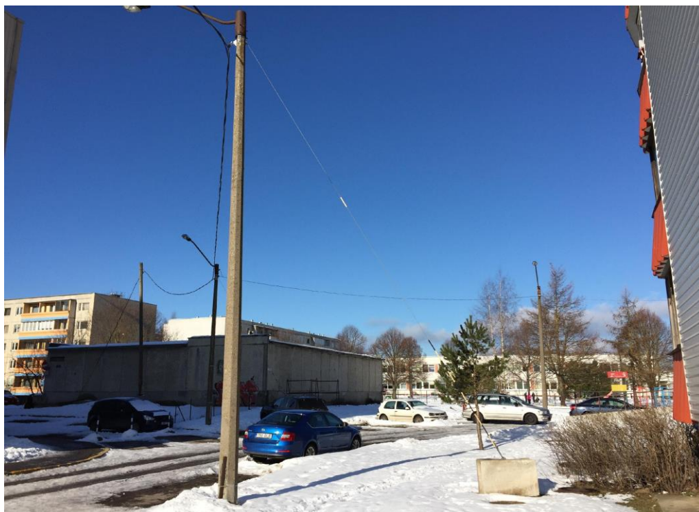
Joonis 5.4 Olemasolev tänavavalgustuse betoonmast koos lisatud tõmmitsaga.
