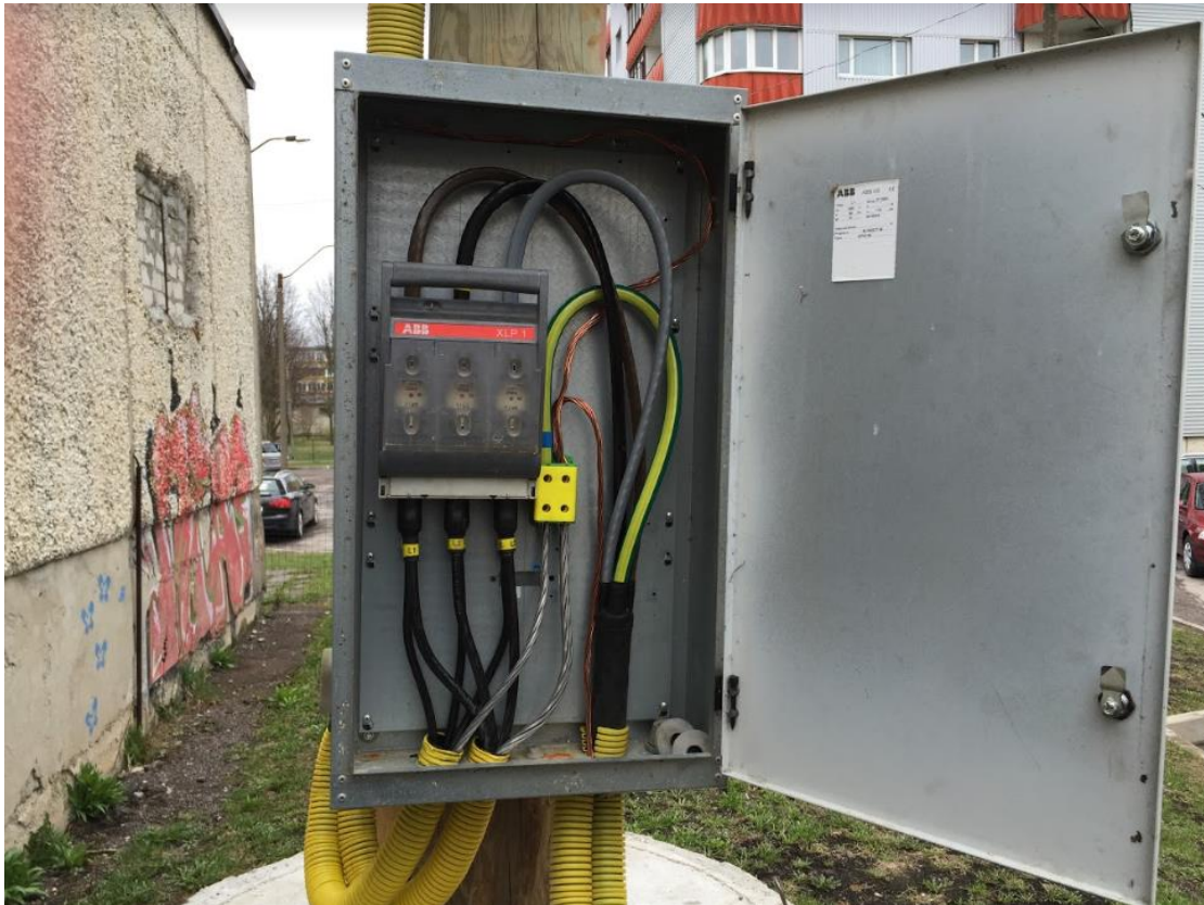
Joonis 5.7 Alajaama kõrvale ajutisele mastile kinnitatud jaotuskilp 250A vinnaklülitiga ABB XLP1.
