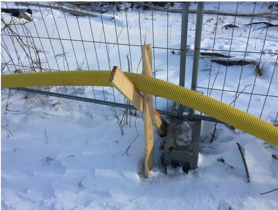
Joonis 2.3. Kaablikaitsetorus kaabel puithargil
