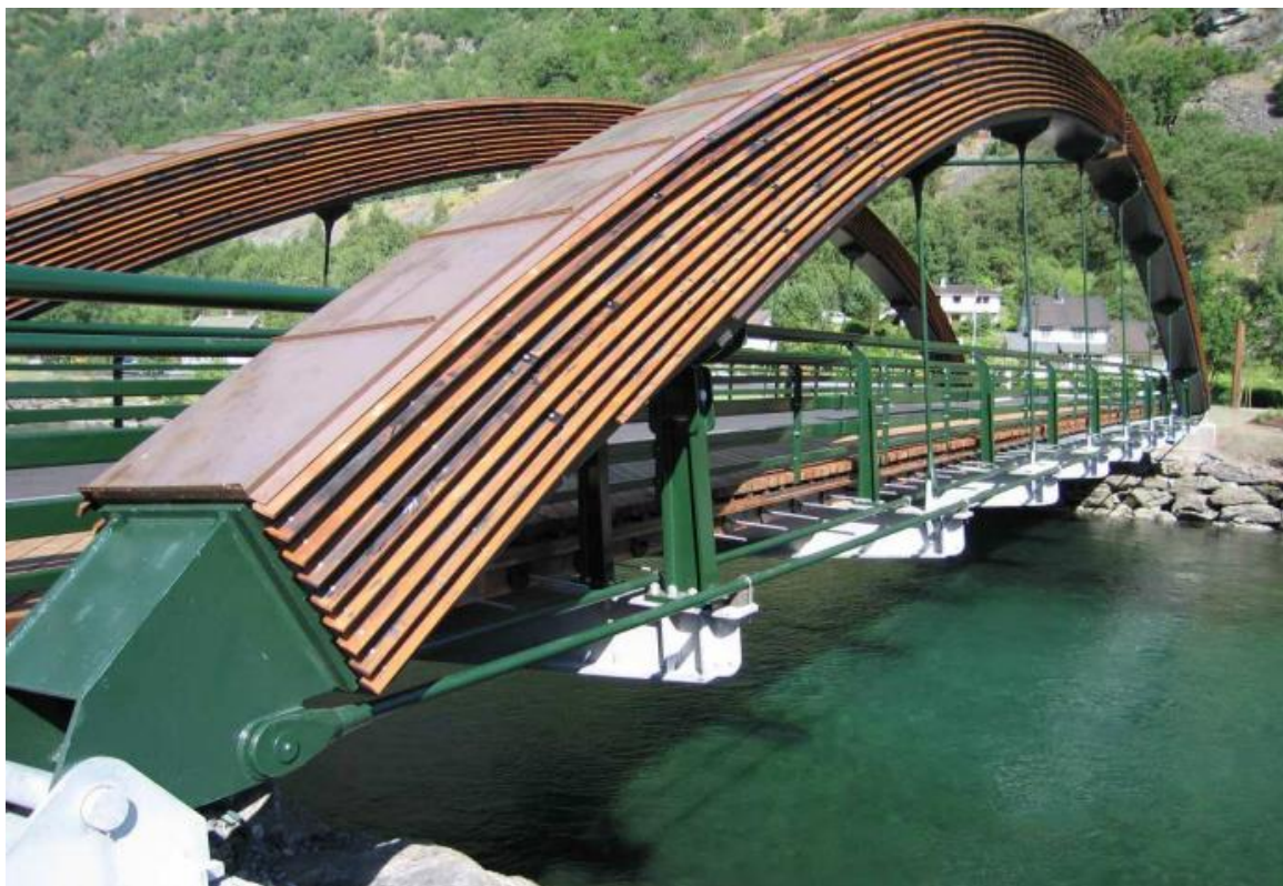
Joonis 2.3.2.1 Ülapinnalt vask-lehtedega ja külgedelt tuulutava puitvooderdusega kaetud sild. Foto autor: Rune Abrahamsen, SWECO Gröner AS
