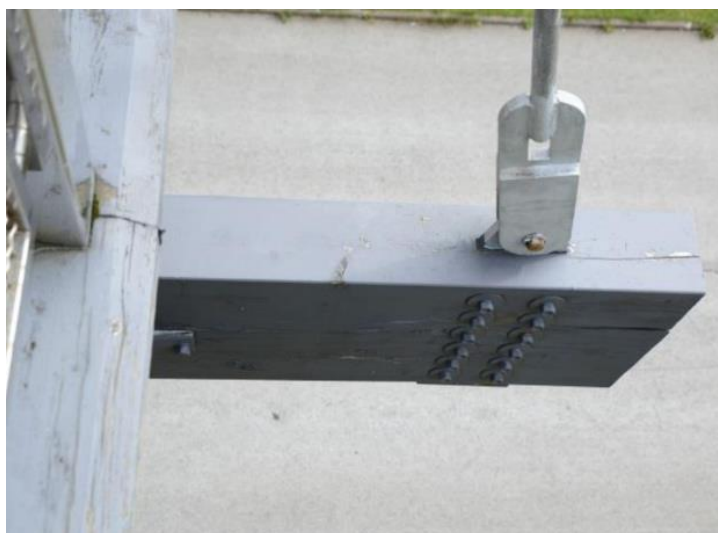
Joonis 3.4.1.6 Vasakul tuulutuspõiksuunaga metallist kate, [23] paremal katmata kahjustunud põiktala [21].
