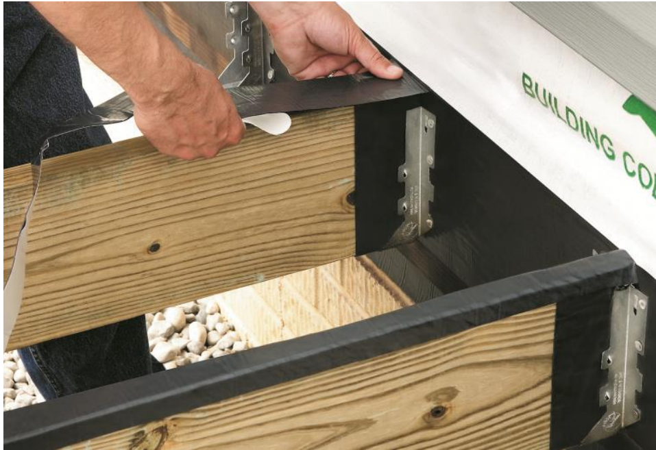
Joonis 3.4.1.4 Veekindla membraaniga kaetud talad. Foto autor: MFM Building Products.
