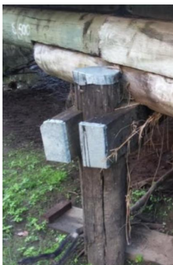
Joonis 3.4.1.6 Vasakul tuulutuspõiksuunaga metallist kate, [23] paremal katmata kahjustunud põiktala [21].
