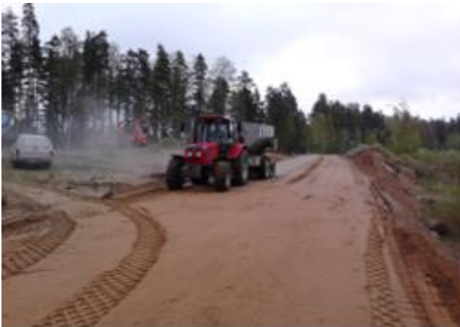
Joonis 4.2: tsemendi laotamine Kalajärve karjääris
