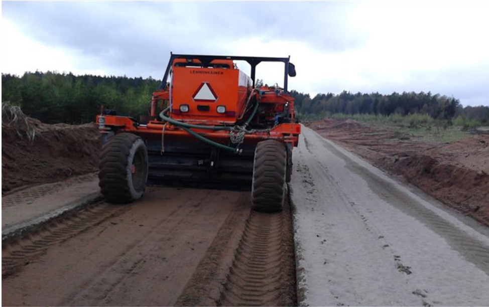
Joonis 4.3: Olemasoleva liiva ja tsemendi segamine 1990 aasta CAT stabilisaatoriga
