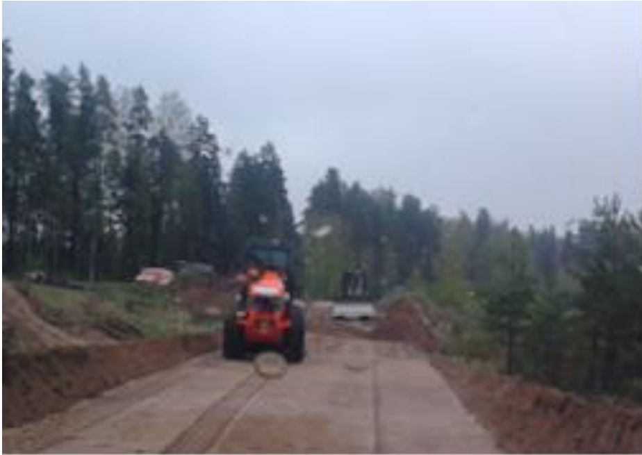
Joonis 4.1: Aluse stabiliseerimine Kalajärve karjääris
