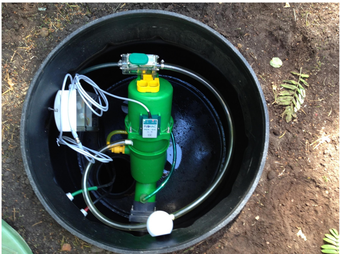
Joonis 12. Vaakumkaev koos vaakumklapi ning kontrolloriga
