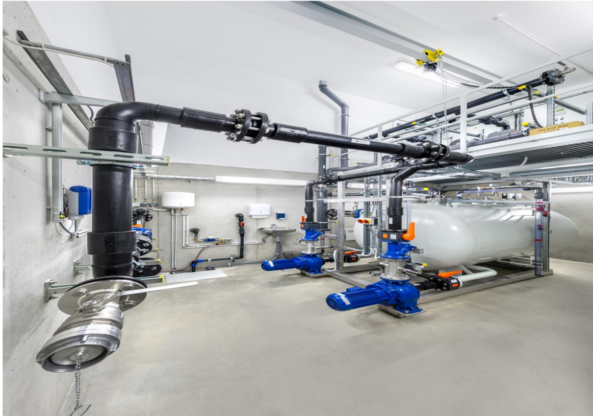
Joonis 21. Kuivasetusega horisontaalne reoveepump [13].
