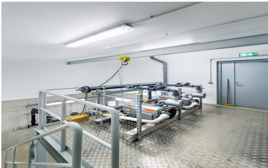
Joonis 20. Õhufilter vaakumpumba ja ventilatsioonitoru vahel [13].
