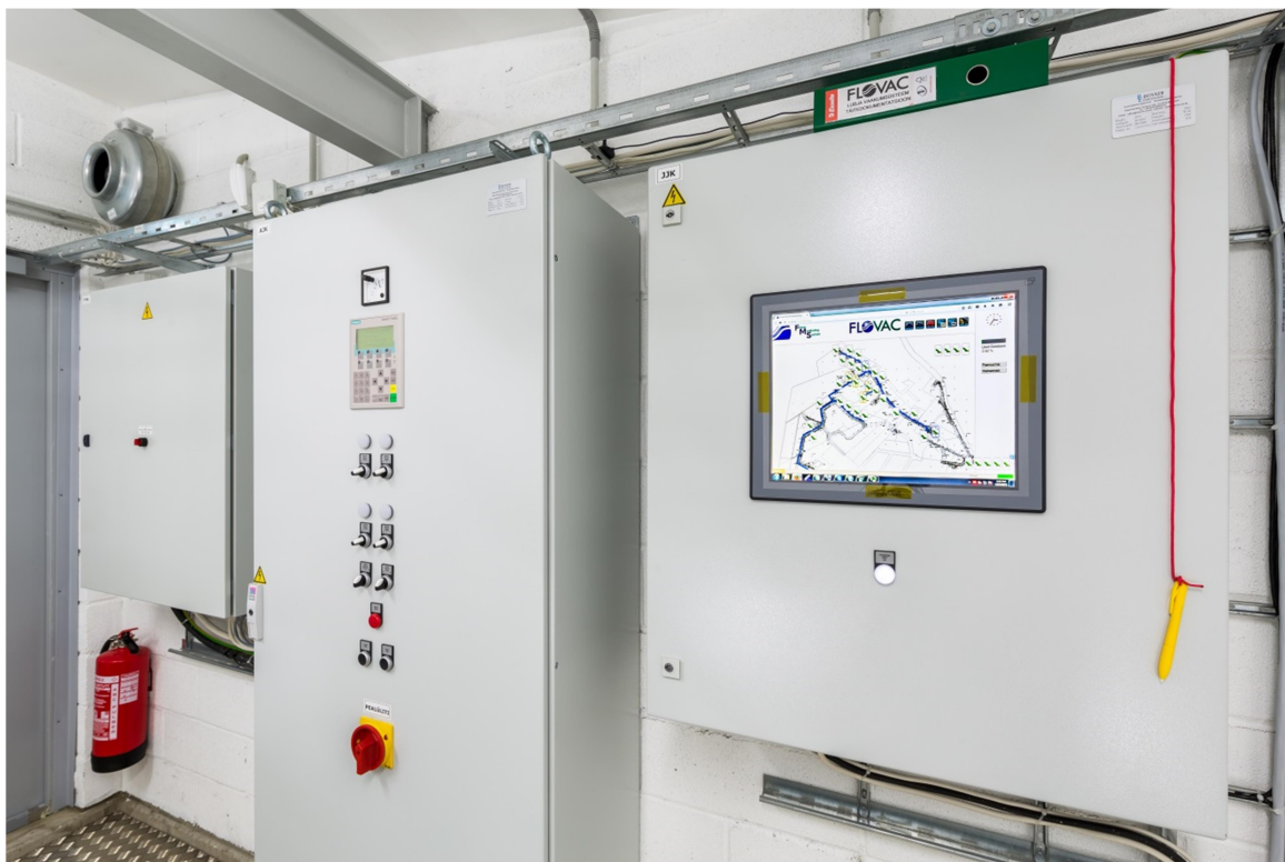
Joonis 23- vaakumpumpla juhtimis- ja automaatikakilp [13]
