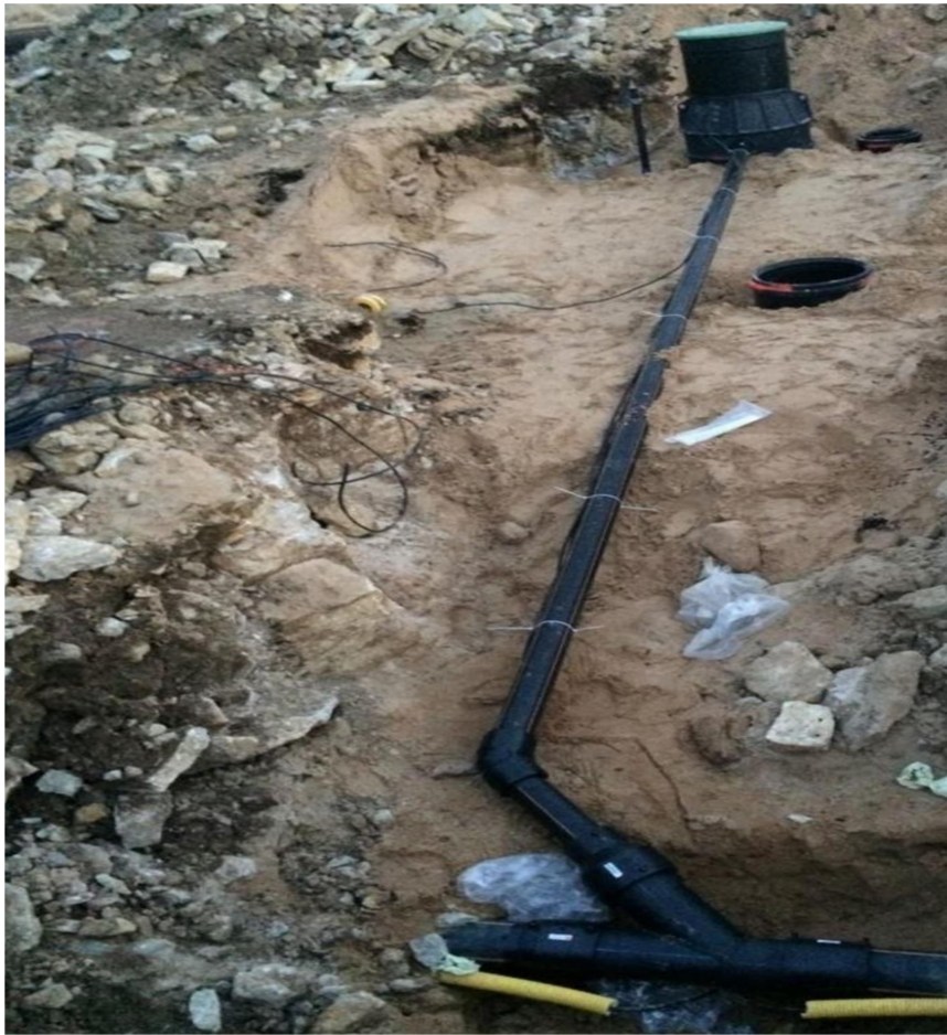
Joonis 16. Foto magistraali ja ühendustoru sõlmest
