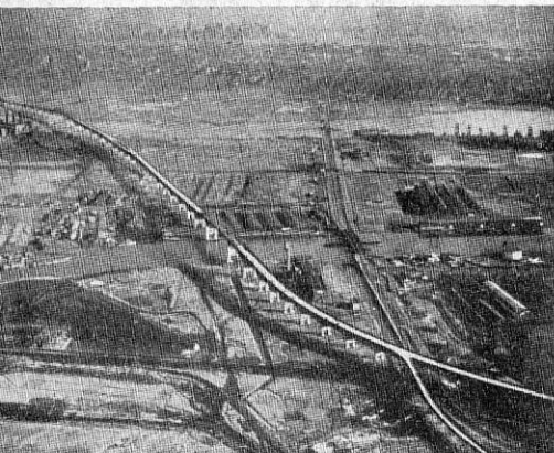
ny nr.1 teeosa asustatud maakohas. Pildil — teraskonstruksioon-kõrgtee
