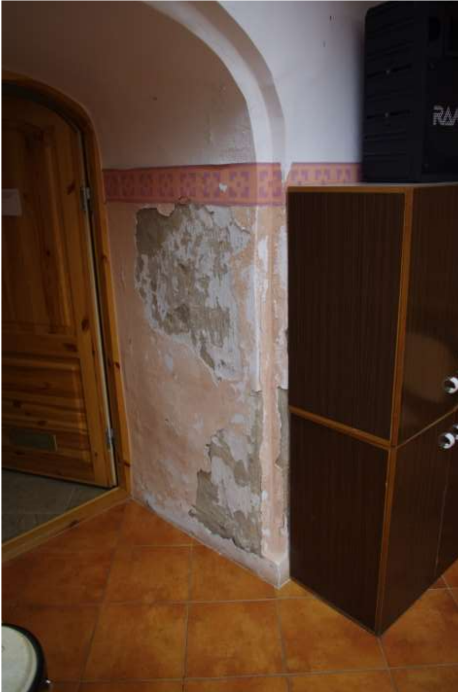
Pilt 17: Klassiruum 1 ukseava. Lagunenud krohv. Krohv on seina küljest lahti. Pudenev värv.
