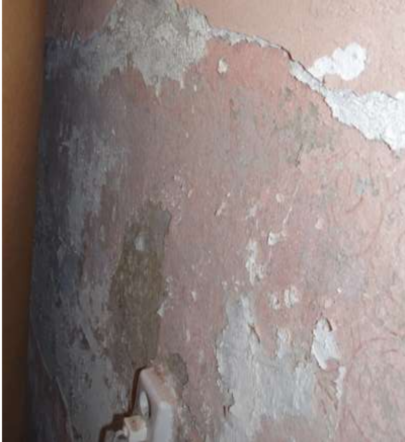
Pilt 13: Klassiruum 4 välissein. Krohv koorub seinalt maha. Vanad krohvi ja värvi kihid on jäetud uute alla. Pudenev värv.
