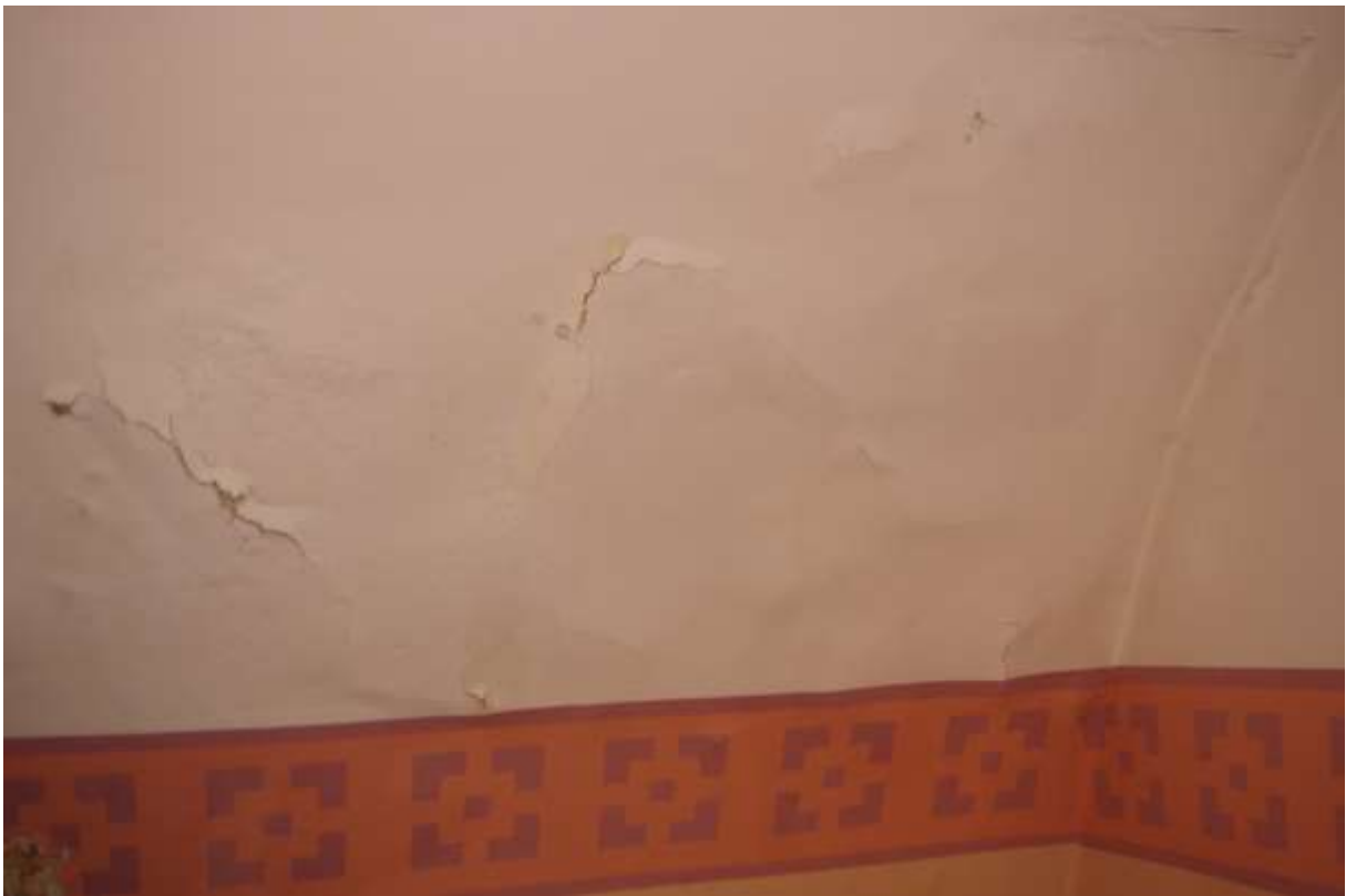
Pilt 16: Klassiruum 1 välisseina ja võlvlae nurk. Krohv on seinä küljest lahti.
