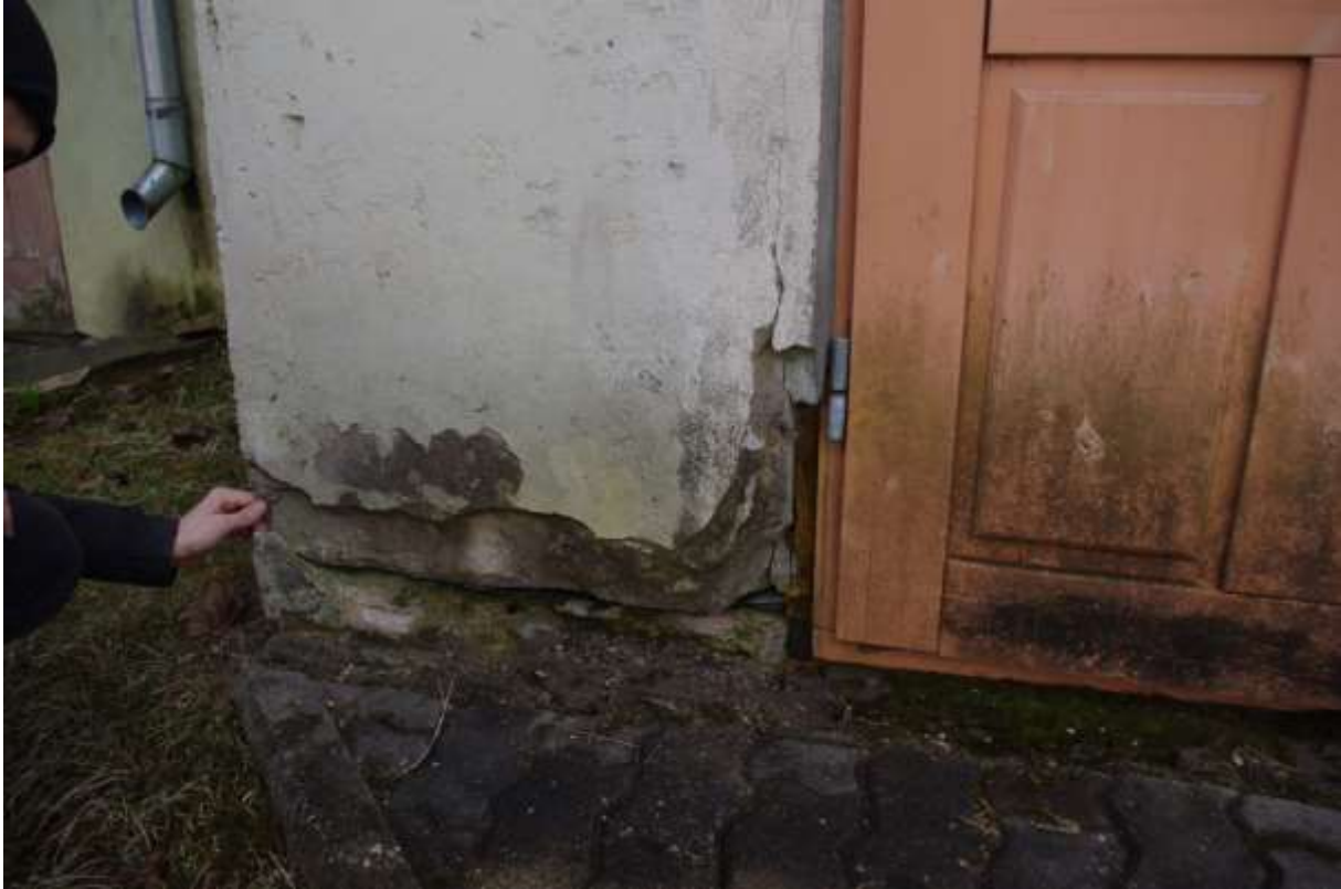
Pilt 5: Hoovipoolse külje väike eeskoda. Lagunenud betoon. Iseloomuliku horisontaalse prao sees on näha niiskustakistust kapillaartõusu tõkkeks.
