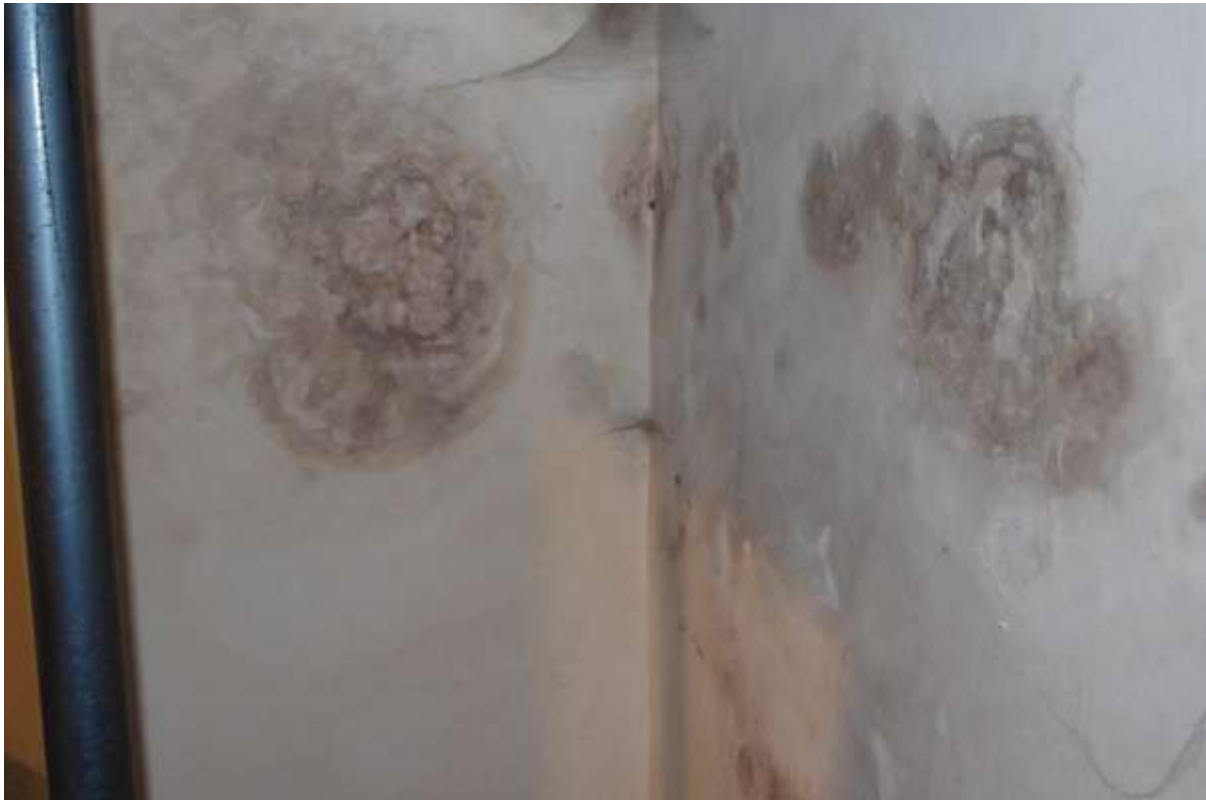
Pilt 12: Abiruum 7. Krohvikahjustused. Krohv on värvunud tumedamaks ning osaliselt puudu.
