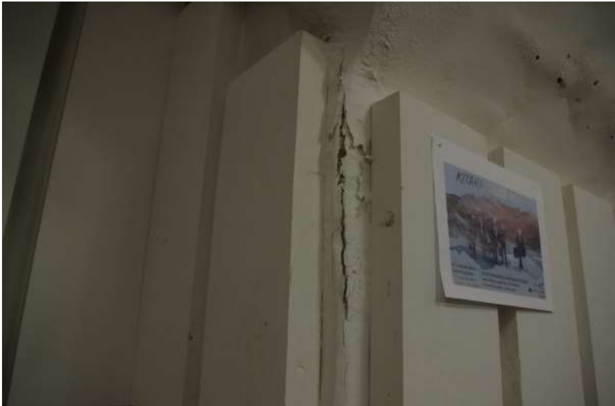
Pilt 10: Klassiruumi 10 välisseina süvendi nurk. Mahakooruv pragunenud krohv. Kapillaarniiskusest laevõlvi küljest lahti oleb krohv.
