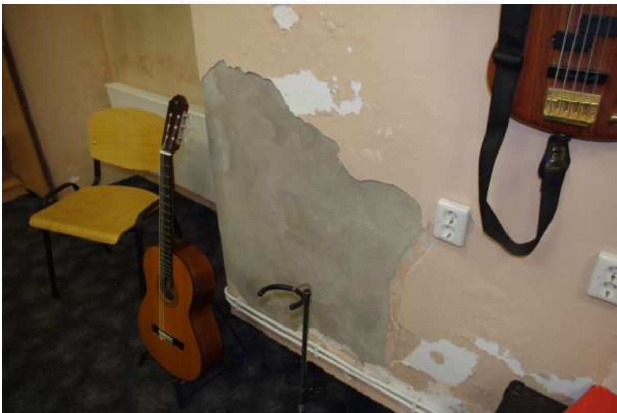
Pilt 11: Klassiruum 10 välisseina süvendi nurk. Krohv on uelt tasanduskihilt maha tulnud. Värv koorub krohvilt maha.
