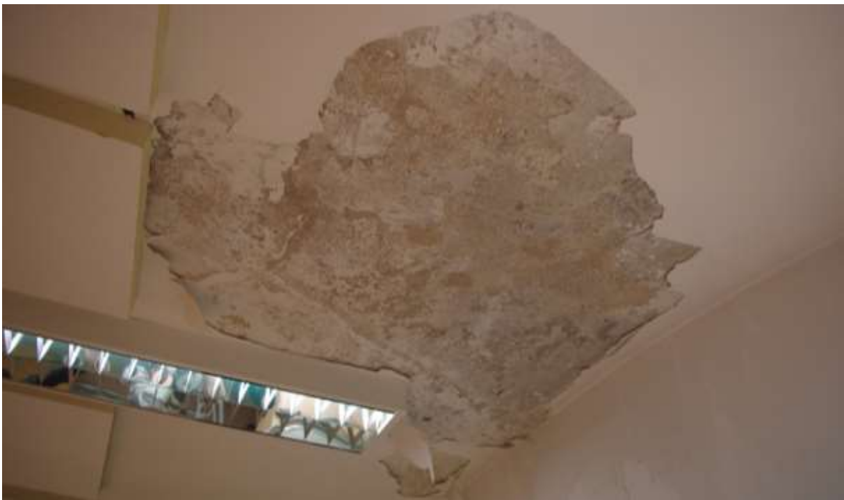
Pilt 14: Klassiruum 4 võlvlae välisseinapoolne külg. Krohv ei püsi laes. Seinal on näha pragusid.
