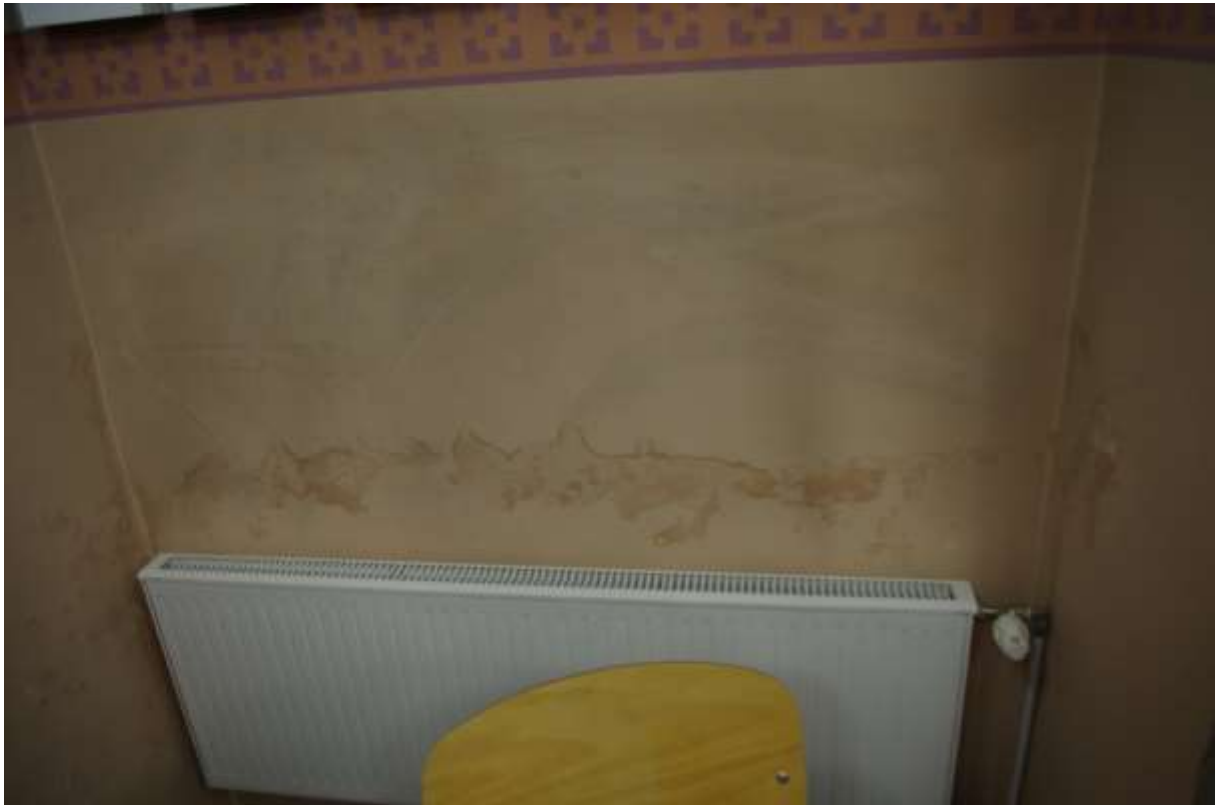
Pilt 9: Klassiruum 10 radiaatori kohal olev niiskuskahjustus. Kondensvee teke peale kütmist.
