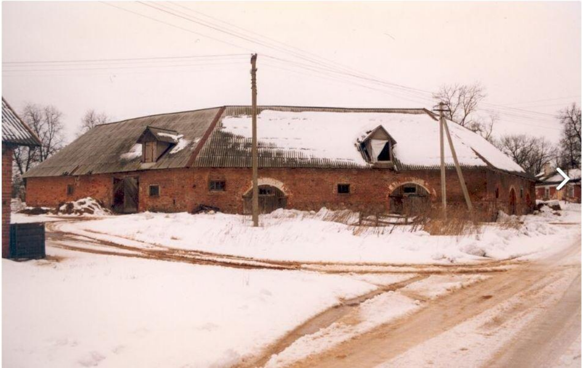
Foto 3. Torma mõisa ringtalli vaade kirdest, J. Vali, 1997 [17]
