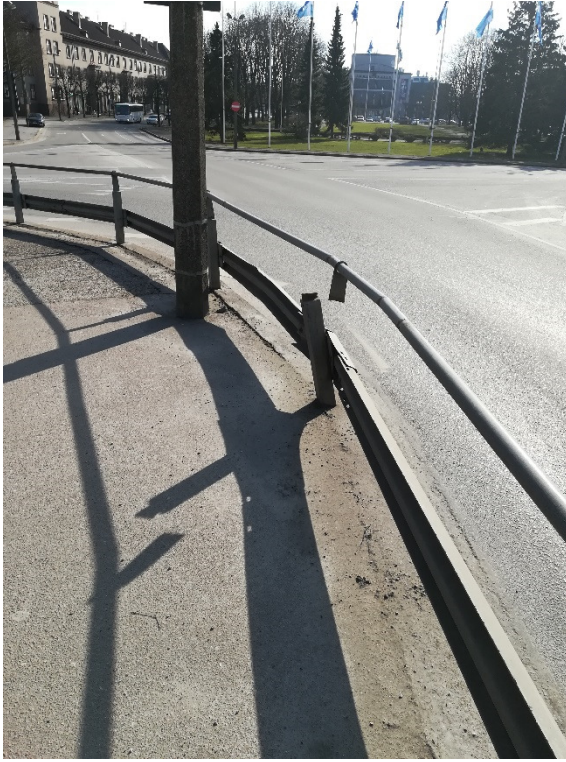
Fotod 4.6 ja 4.7 Deformeerunud piire
