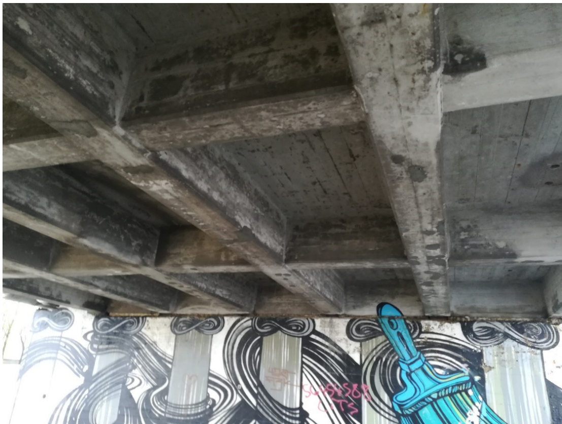
Foto 2.3 Pealesõidu raudbetoonist ribidega plaat
