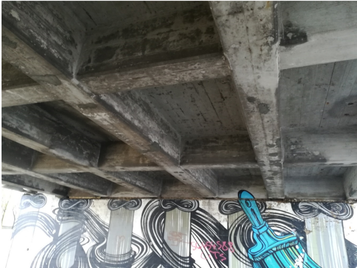
Foto 4.13 Raudbetoon ribiplaat üldiselt rahuldavas seisus
