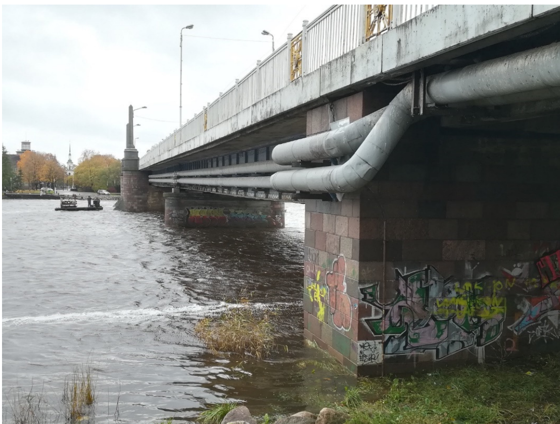
Foto 2.4 Jõepoolsele küljele kinnitatud kaugkütte trass1
