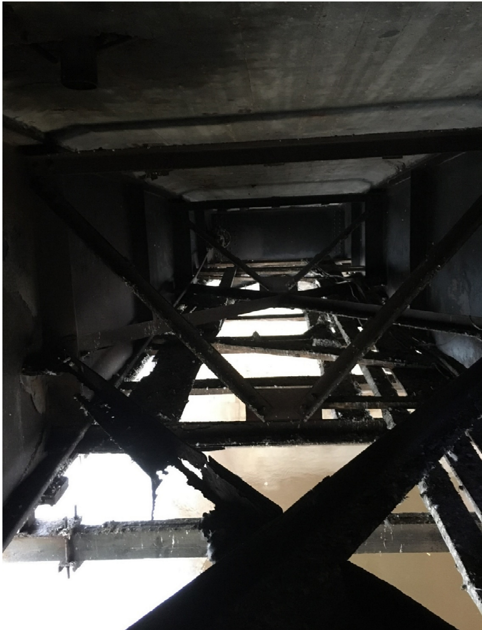
Foto 4.12 Klapitala diagonaalid on kohati täiesti läbikorrudeerunud (Erki Reinsalu)
