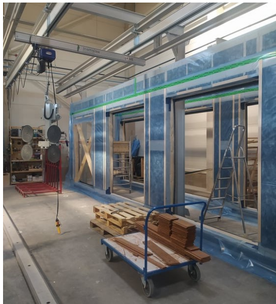
Joonis 2.10 Akende paigaldamine ja vaakumtõstuk Welement AS tehases
