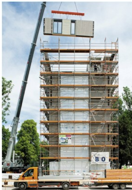
Joonis 4.1 Elementide paigaldus objektil (Saksamaa) [19]
