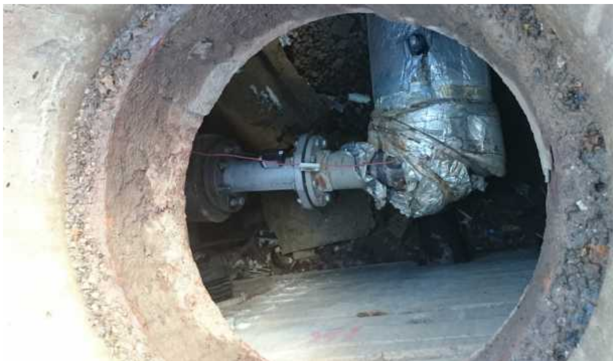
Joonis 4.4. Magistraalsoojusarvesti vooluhulgamõõturi Ultraflow paigutus kaugküttetorustikul K-J-
