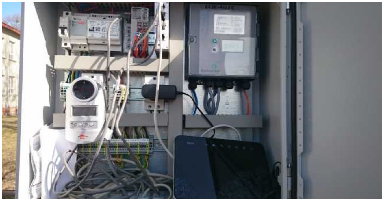
Joonis 4.3. Magistraalsoojusarvesti K-J-1, koos GSM modemiga
