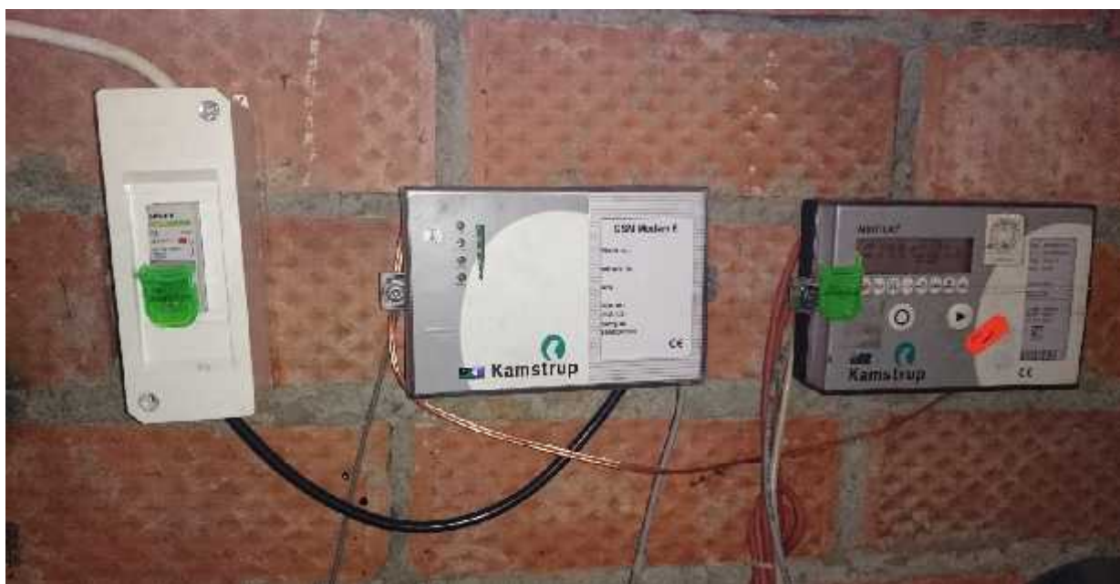
Joonis 4.5. Soojusarvesti koos GSM modemiga tarbijapaigaldises
