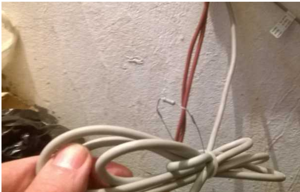
Joonis 4.11. Ühendatud takisti tarbijapaigaldises
