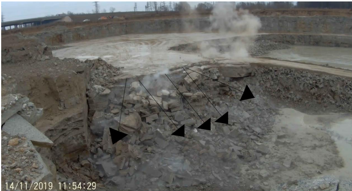
Joonis 22. Laialipaiskuvad kivimikildude suund videode põhjal.
