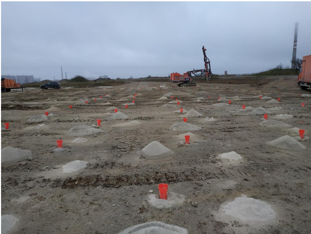
Joonis 6. Lõhkeaukude puurimine Sillamäel 11.06.2018. Autor: Siim Eensoo.
