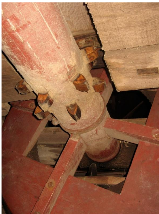
Joonis 2.2. Etteanderaami edasivedav võll [9]
