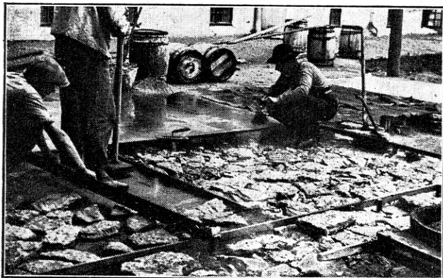
Joon. 1. Hoovikatte valmistamine. Esiplaanil näha mahalaotud paekonkrad; keskel tööline tambib keskkihti, teine paneb sellesse peenemaid kive; tagaplaanil käib pealispinna hõõrumine.
