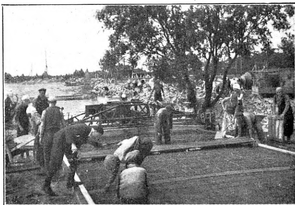
Joon. 1. Betoonitee ehitamisel — vuugišabloonide panemine.
