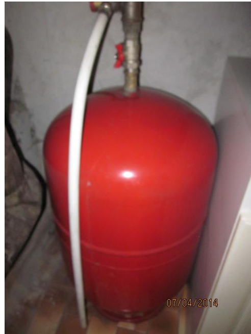
Joonis 5.7. Keskküttekatel (vasakul pildil) ja paisupaak (paremal pildil)
