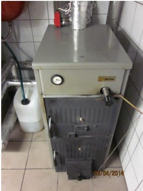
Joonis 5.7. Keskküttekatel (vasakul pildil) ja paisupaak (paremal pildil)
