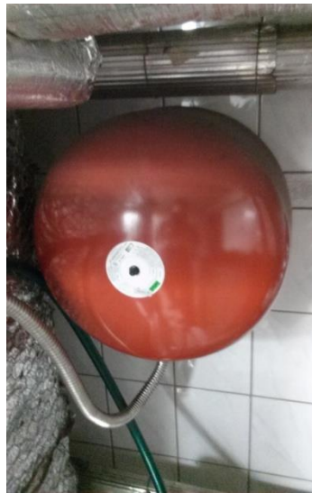
Joonis 5.4. 50 liitrine paisupaak (vasakul pildil) ja antifriisi väljalaskepaak (paremal pildil)
