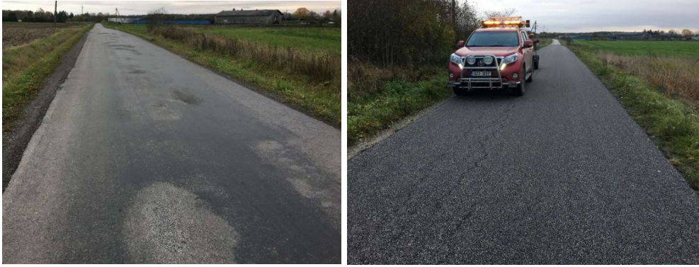
Fotod 3.6 ja 3.7. Pajupea tee külmakerkeline seksioon. Vesiroosi teel leidus hulgaliselt võrkpragusid.
