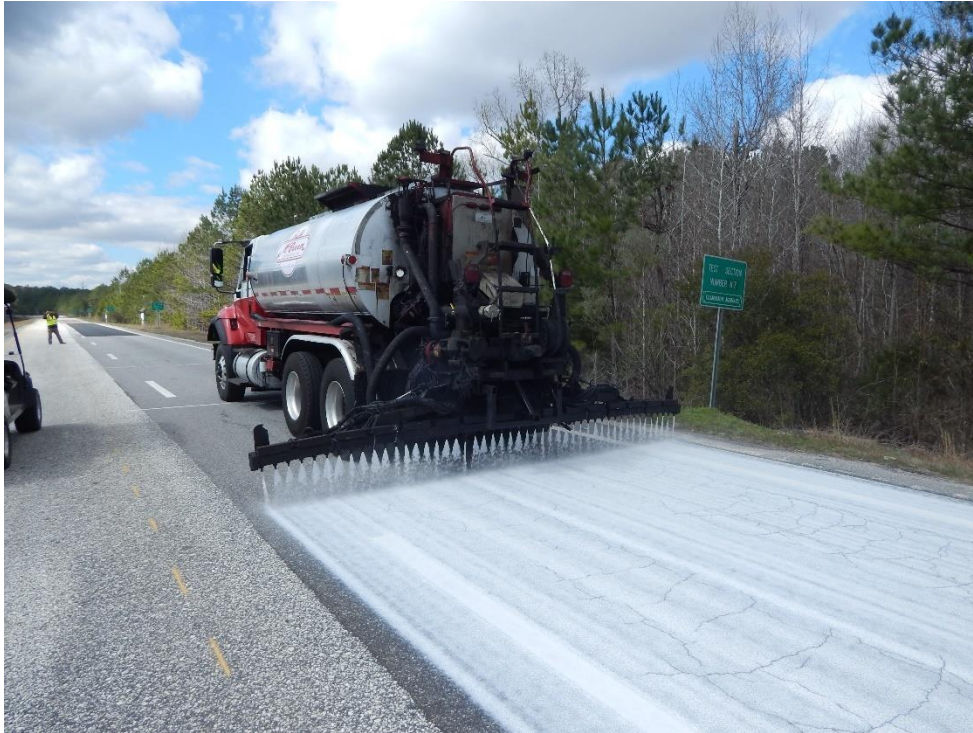
Joonis 3.2 Rejuvenaatori pihustamine asfaltkate pinnale [48]
