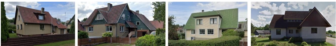
Figure 4.75 Examples of individual post-1980 gable houses (left to right: Lõuna 8 (1986), Lõuna 6 (1986) and Loode 15a (1987) in Karksi-Nuia; and Põllu 3 (1992) in Väike-Maarja)
