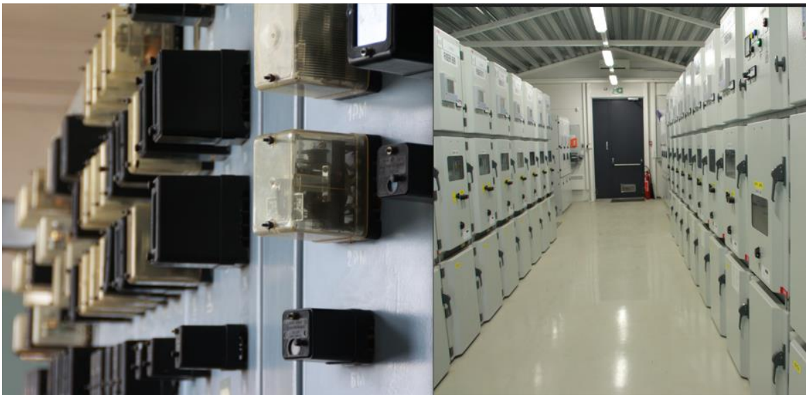
Joonis 1.5 Vana ja uus alajaama sekundaarsüsteem
