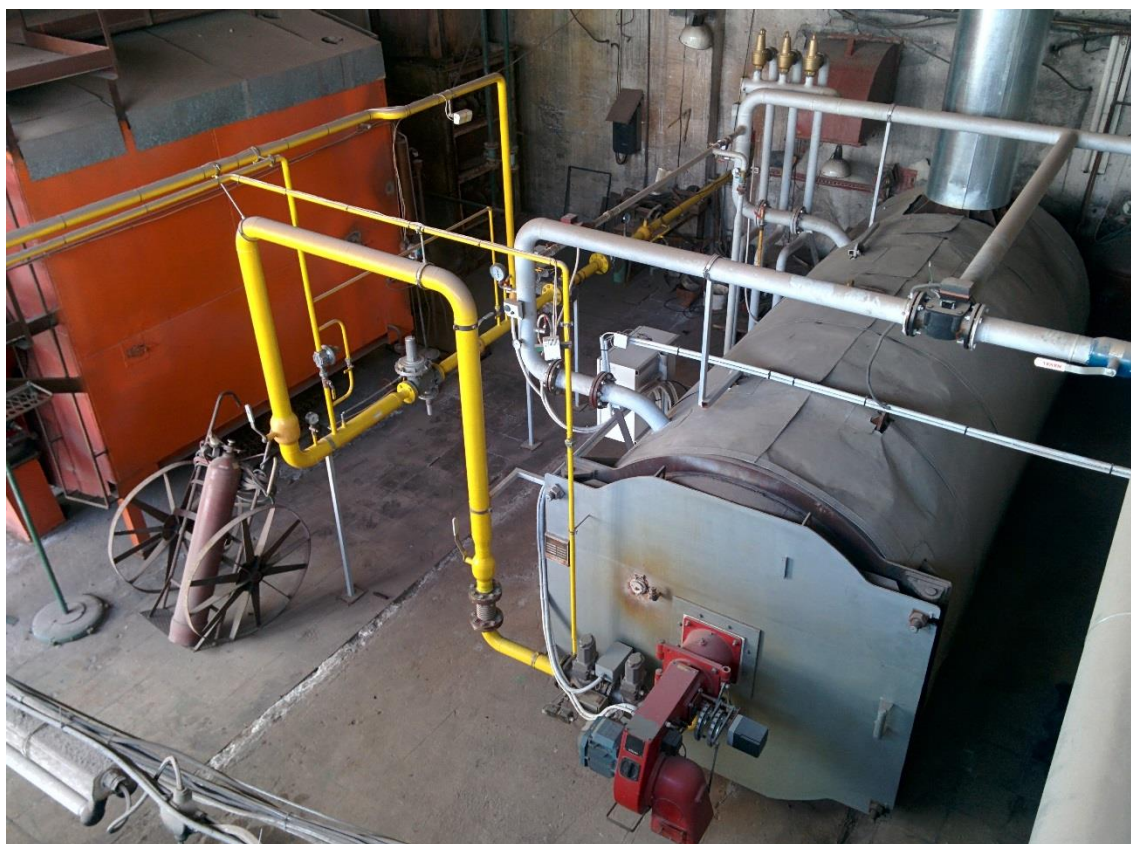
Sele 7.1. Haljala katlamajas olemasolevad katlad – 3,0 MW leeksuitsutoru katel Thermax RF W 3000 ning tagaplaanil demonteeritava aurukatla korpus.
