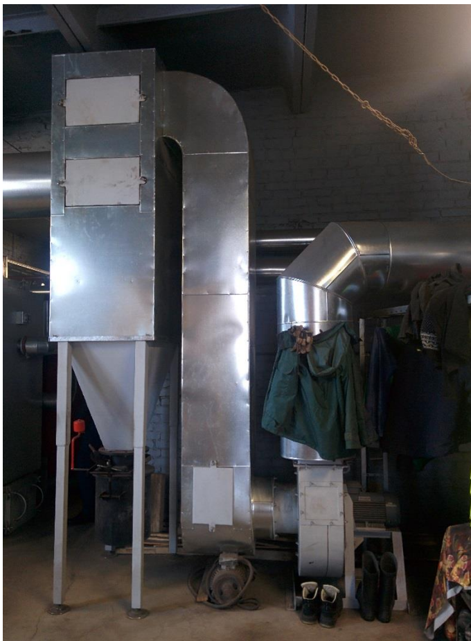
Sele 9.4. Komforts Kapak katlale paigaldatud multitsükolon (vasakul) ja suitsugaaside ventilaator (paremal) Reola katlamajas Tartumaal. [20]
