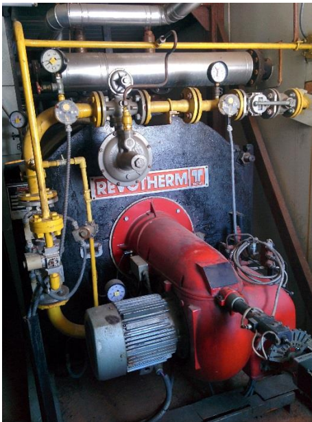
Sele 5.2. Gaasipõleti (punast värvi), leeksuitsutoru katel (must) ning gaasitrass Tartumaa, Ülenurme katlamajas.
