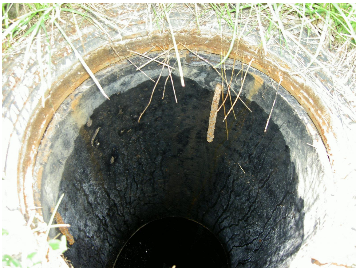
Joonis 10. Mittekorrektne kaevu parandamine. Kaev L-J4.
