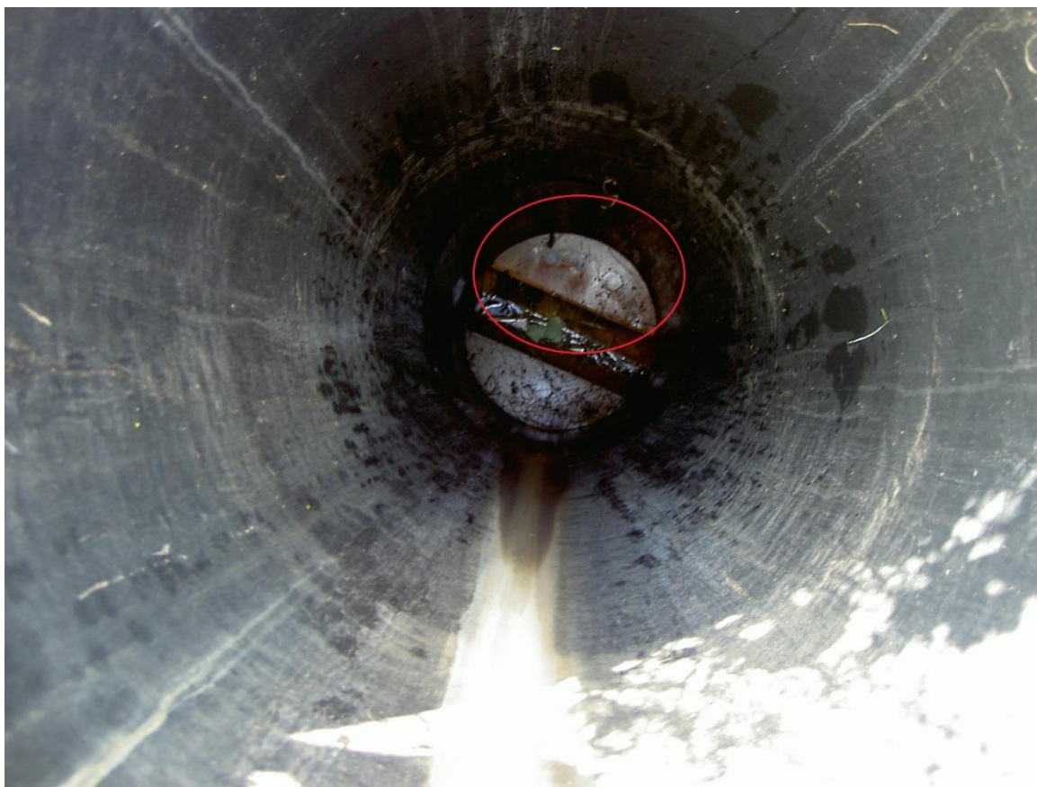
Joonis 8. Vee tilkumise jäljed kaevu põhjal. Kaev L-J7.
