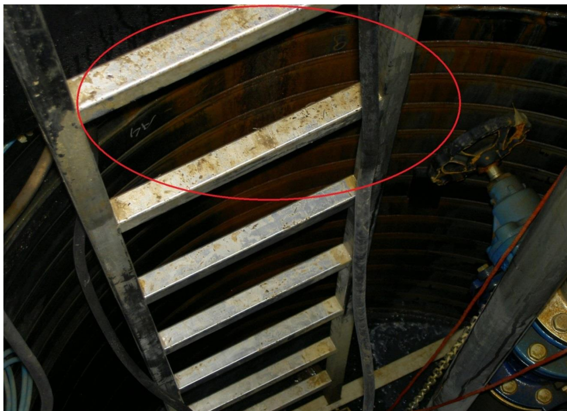
Joonis 11. Võõrvee sissetung reoveepumplasse. Kangilaski reoveepumpla.
