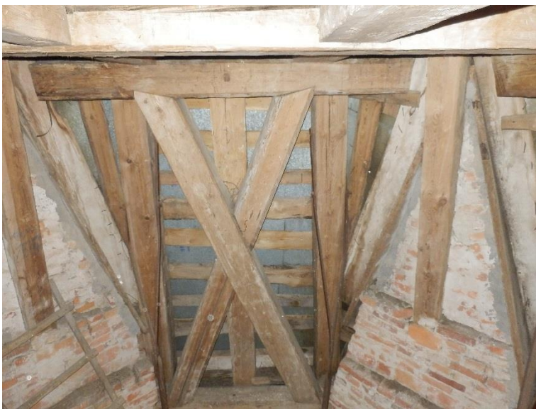
Joonis 2.9. Maarja-Magdaleena kiriku tornikiivri konstruktsioonide liide tornitüvesega
