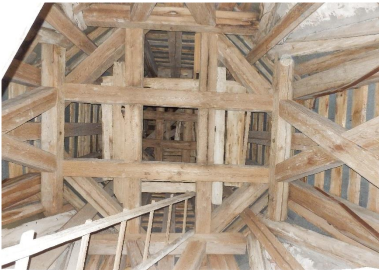
Joonis 2.8. Maarja-Magdaleena kiriku tornikiivri konstruktsioonid vaatena alumiselt platvormilt ülemiste suunas
