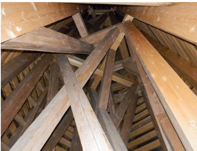
Joonis 2.5. Väike-Maarja kiriku tornikiivri südamiku konstruktsioonid
