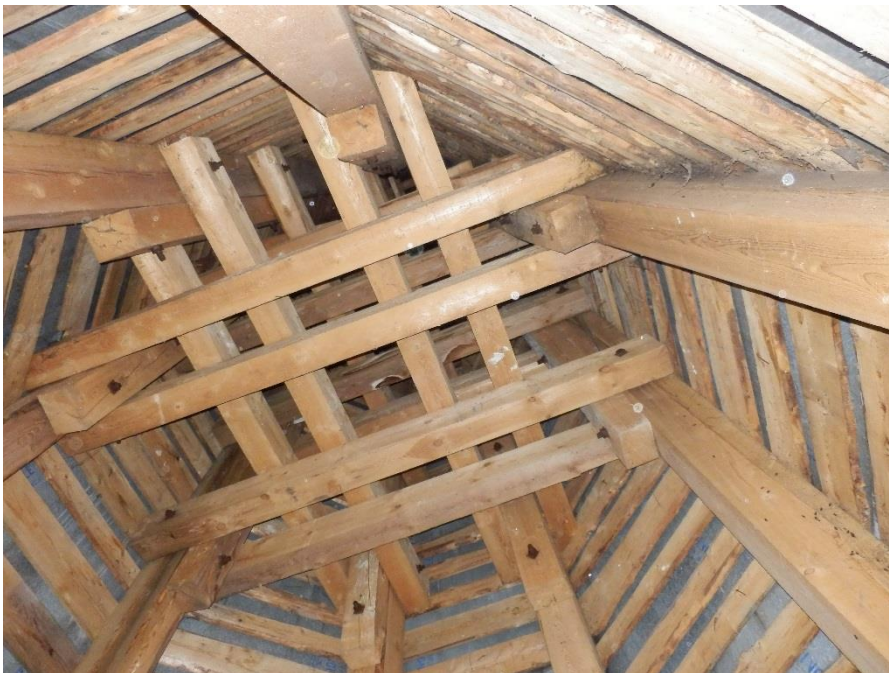
Joonis 2.5. Mustvee kiriku tornikiivri puitkonstruktsioonid seest poolt vaadatuna
