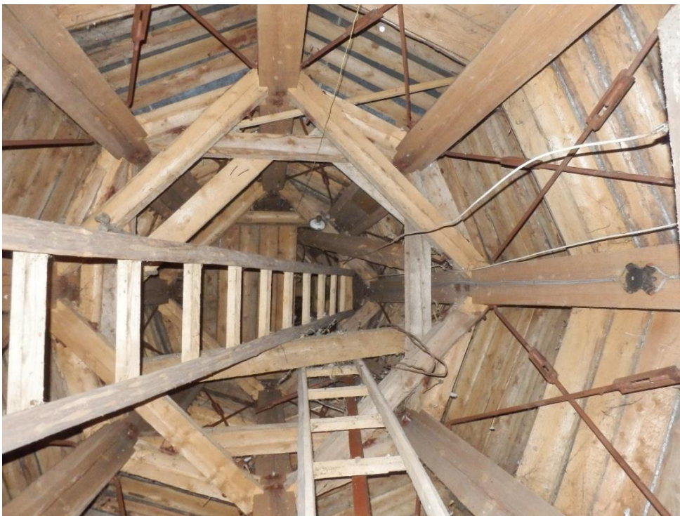
Joonis 2.2. Põltsamaa kiriku tornikiivri puitkonstruktsioonid vaadatuna seest poolt
