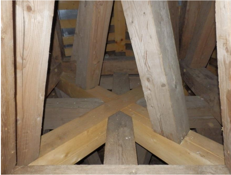
Joonis 2.6. Väike-Maarja kiriku tornikiivri konstruktsioonide liide
