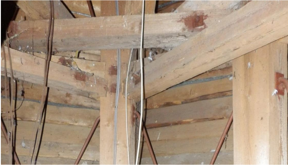
Joonis 2.3. Põltsamaa kiriku tornikiivri puitkonstruktsioonide sõlmede näide
