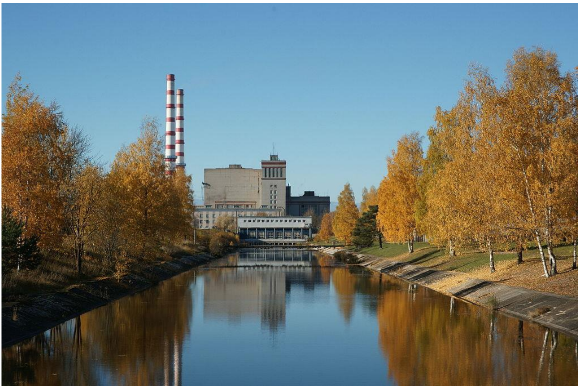
Pilt 2. Balti Soojuselektriijaam sügisel 2015. Pildi autor: Andres Meesak
