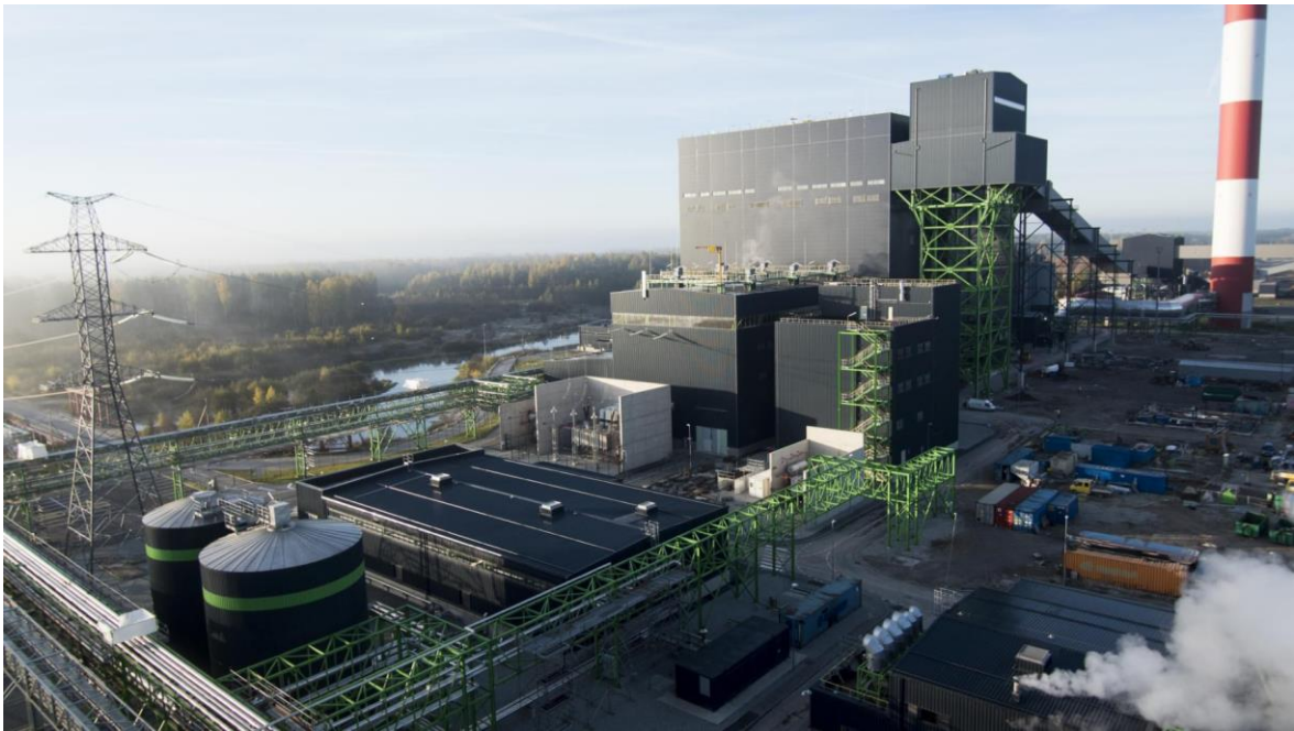
Pilt 3. Auvere elektrijaam. Pildi autor: Eesti Energia
