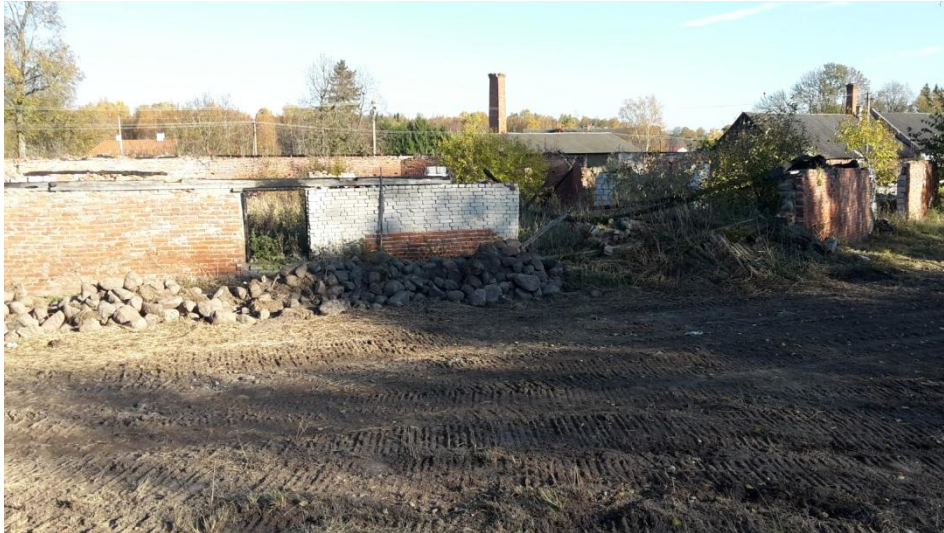
Foto 6.2. Maakivihunnikud, hoones kasvav võsa ja põlengujärgsed puitkonstruktsioonid.
