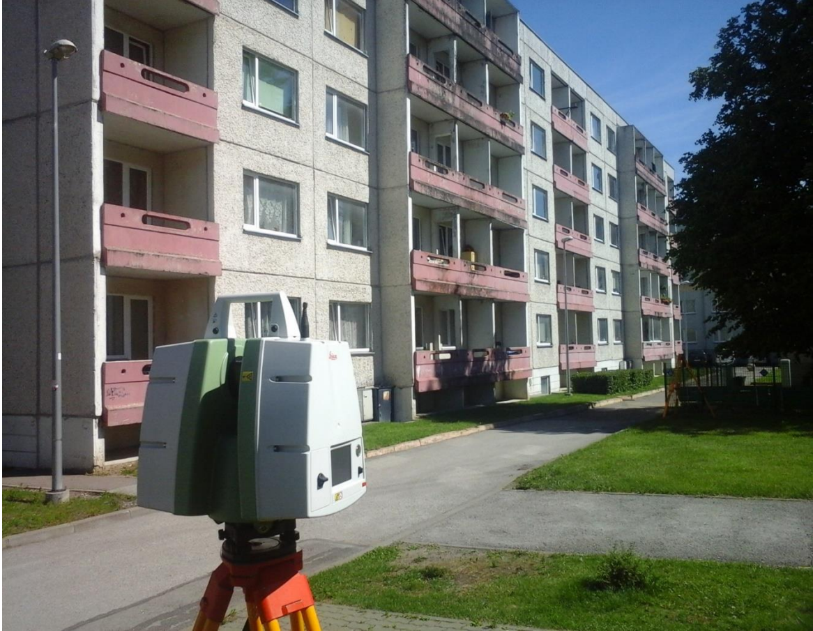
Hoone (TTÜ ühiselamu Akadeemia tee 5a) renoveerimiselne mõõdistamine laserskanneriga (esiplaanil)
