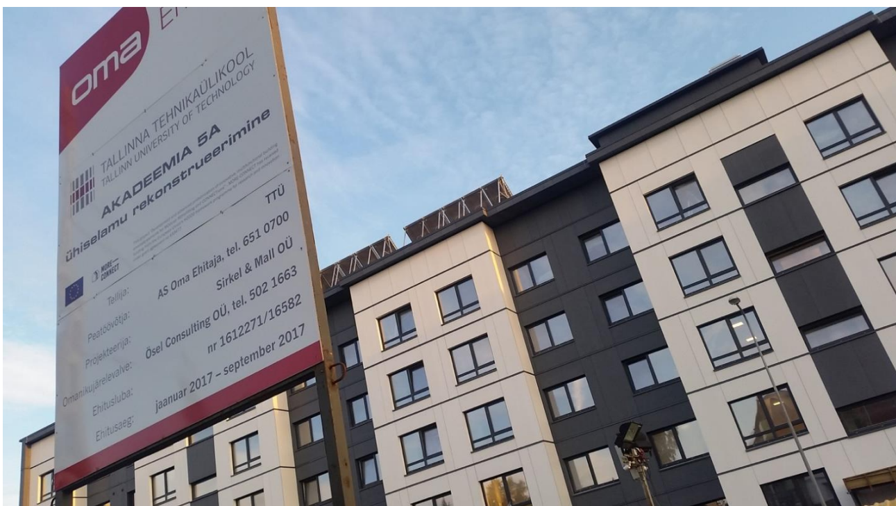
H2020 More-Connect projektis liginullenergiahooneks renoveeritud TTÜ ühiselamu Akadeemia tee 5a.
