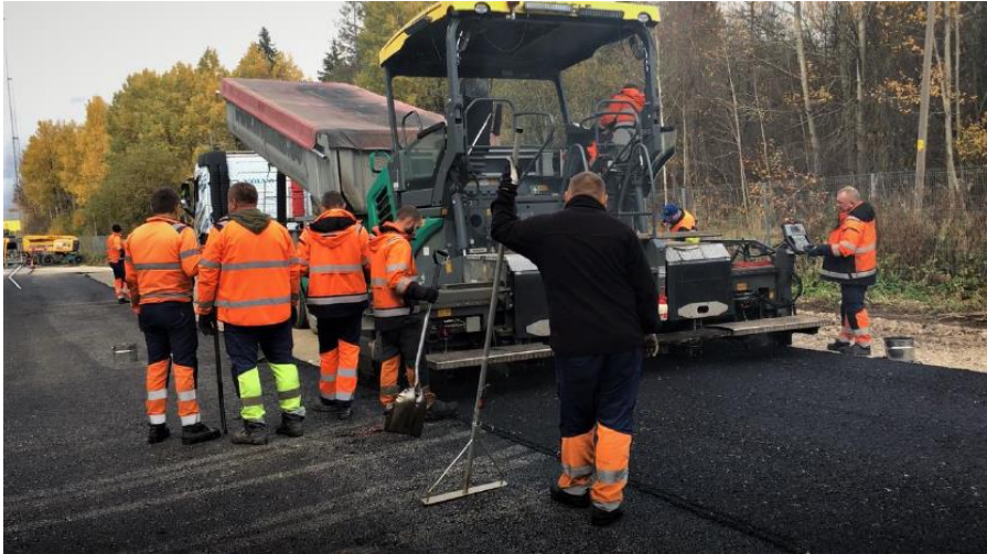
Joonis 2. Ligniini sisaldava asfaltsegu paigaldamine ei nõua teistsuguseid paigaldustehnoloogiaid
