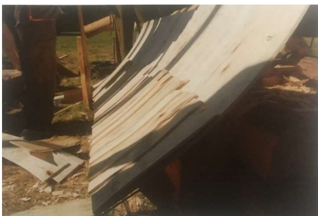
Joonis 1.8 Teise rea laastude löömine (Metslang, 2012)
