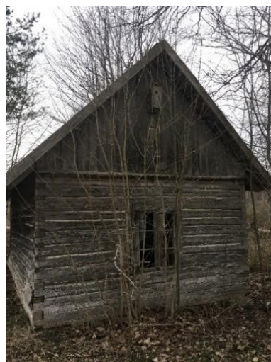
Joonis 5 Pehkinud välissein
