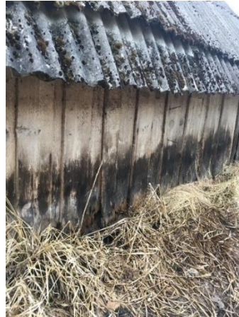
Joonis 3 Niiskuskahjustustega ning kiiva vajunud servamata laudadega kaetud sein
