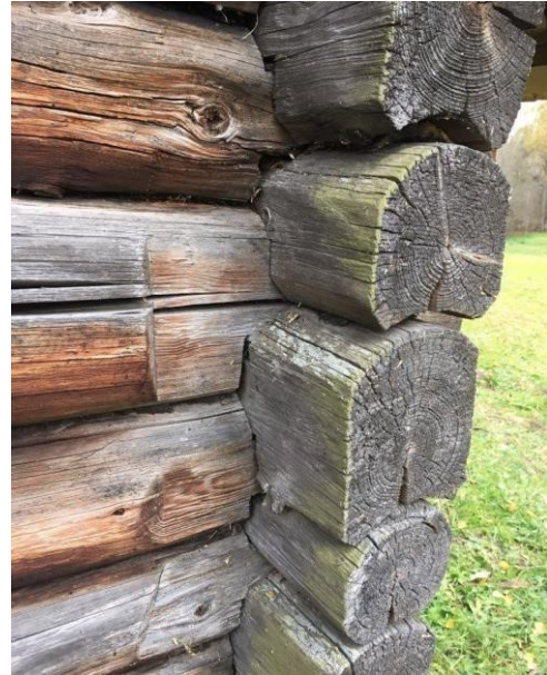
Foto 2 ja 3 Fotodelt on näha, et tegu on kooritud ümarpalkidega, mille nurgaseotiseks on järsknurk. Järsknurga puhul on palgid külgedelt saetud. Köetavale ehitisele omaselt on palgid ka varatud, täpsemini on tegu lahtise varaga.
