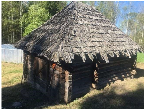
Joonis 3.5 Kelpkatus kaetud väljavahetamist vajavate laastudega
