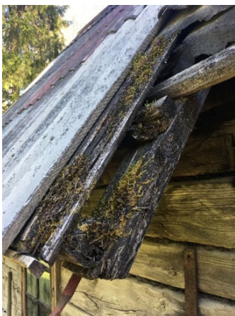
Joonis 5 Niiskuskahjustustega sarikas ja roovide otsad
