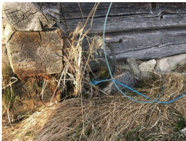
Joonis 3.1 Vundamendikivid ja alumiste palkide niiskuskahjustus
