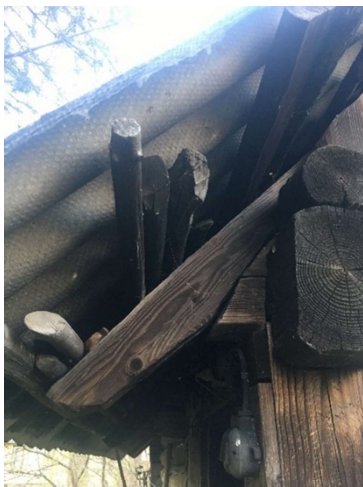
Joonis 7 Heas seisukorras säilinud sarikas
