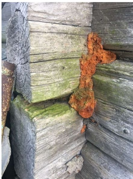
Joonis 3.3 Montaaživahu kasutamine ja niiskuskahjustuste kolded
