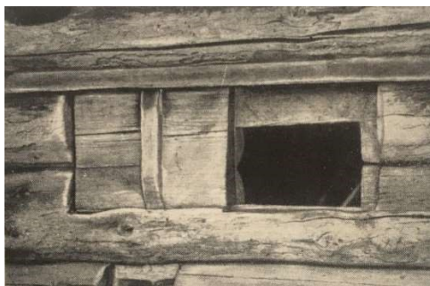
Joonis 1.10 Lükandluugiga suletav pajaaken (Tihase, 1974)
