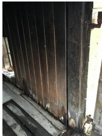
Joonis 5 Mädanenud eesruumi põrand- ja seinalaud
