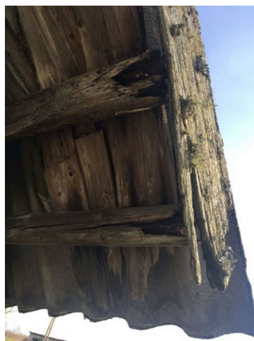
Joonis 8 Mädanenud alumised roovid ja veelaud
