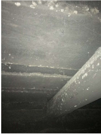
Joonis 5 Tahmaga kaetud vahelagi ja -tala
