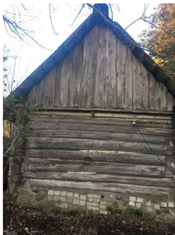
Joonis 4 Telliskividega asendatud alumine palgirida; montaaživahu ja tsementmördiga täidetud palgivahed
