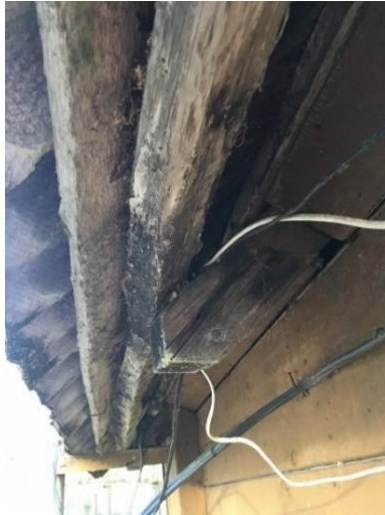
Joonis 6 Niiskuskahjustuste ja mõningase läbivajumisega roovitus
