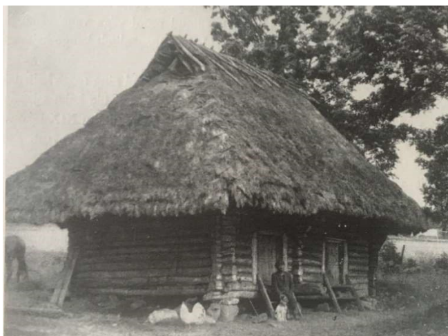
Joonis 1.4 Nurgakividele püstitatud hoone (Tihase, 1974)
