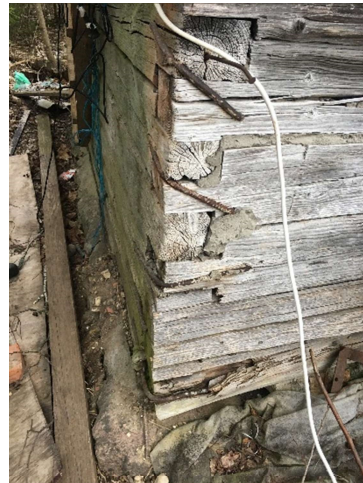
Joonis 3 Palkide vahe tihendamine seguga; palkide omavaheline sidumine metallvarrastega
