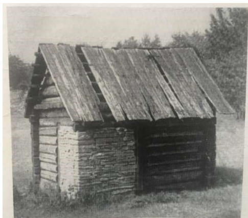
Joonis 1.6 Tellistest välissein kerise asukoha ümbruses (Tihase, 1974)
