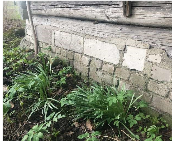
Joonis 3 Silikaattelliste ja betooniseguga sokkel
