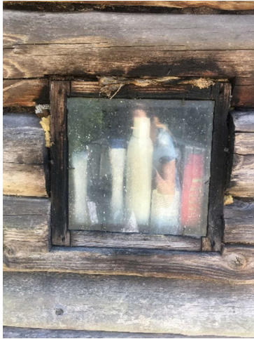
Joonis 6 Säilinud aknaraami ja vahetatud klaasiga aken
