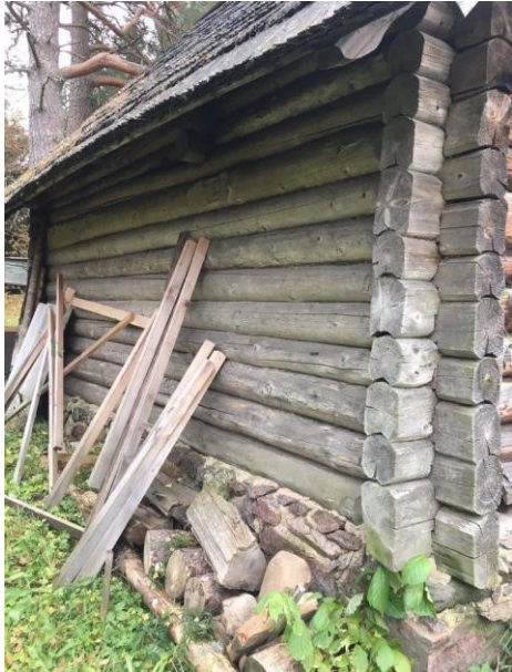
Foto 2 ja 3 Fotodelt on näha, et tegu on kooritud ümarpalkidega, mille nurgaseotiseks on järsknurk. Järsknurga puhul on palgid külgedelt saetud. Köetavale ehitisele omaselt on palgid ka varatud, täpsemini on tegu lahtise varaga.
