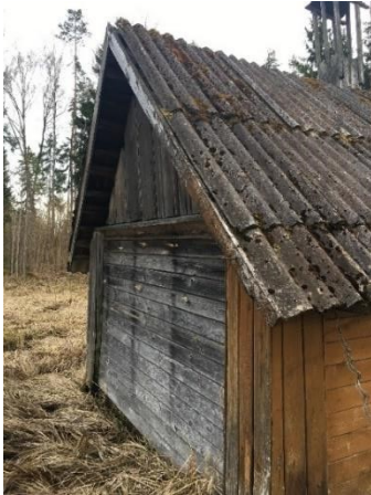
Joonis 2 Algupärane palksein
