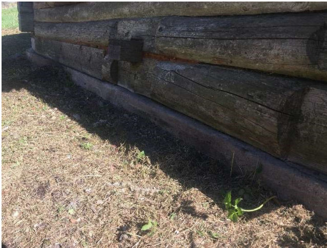
Joonis 2 Betoonpostist vundament
