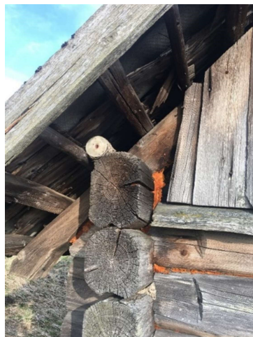
Joonis 6 Montaaživahu kasutamine
