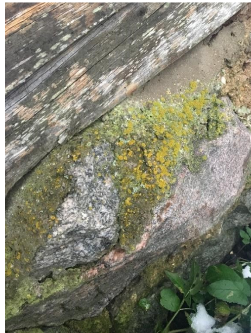
Foto 4 ja 5 Vundamendi soklil on näha sammaldumist, mis praegusel hetkel ei ole veel alumistele palkidele olulist mõju avaldunud. Alumine palgirida oli terava noaga katsudes tugev. Et vältida palkide niiskuskahjustusi, tuleks tegeleda sokli restaureerimisega. Arvatavasti on põhjuse allikaks vanasti kasutatud lubimört, mis tuleks asendada müüriseguga. Esmalt aga tuleb sammal eemaldada ning seejärel asuda vana vuugisegu eemaldamise ja uue vuugitäite paigaldamise juurde.
