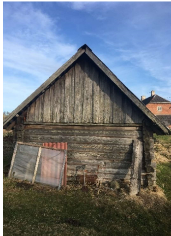
Joonis 2 Kiiva vajunud seinapalgid; seinapalkide proteesimine
