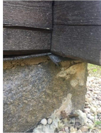
Joonis 2 Vundamendi hüdroisolatsioon
