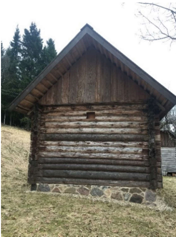
Joonis 3 Välissein kirdest vaadatuna; vanad ja uued palgired
