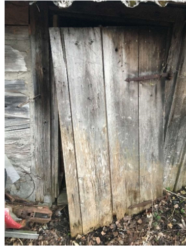
Joonis 6 Vajunud ja niiskuskahjustustega välisüks
