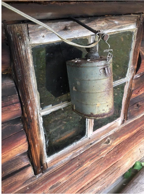
Foto 18 Tegemist on algusaastatest pärit avatäitega. Tegu on puitaknaga, mis valgustab leiliruumi. Aken on täiesti heas seisukorras, ainult klaasil leidub üks mõra.
