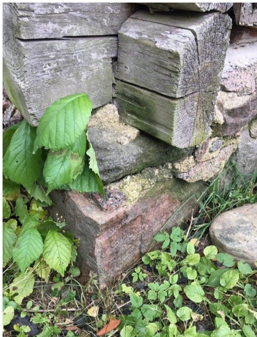
Foto 4 ja 5 Vundamendi soklil on näha sammaldumist, mis praegusel hetkel ei ole veel alumistele palkidele olulist mõju avaldunud. Alumine palgirida oli terava noaga katsudes tugev. Et vältida palkide niiskuskahjustusi, tuleks tegeleda sokli restaureerimisega. Arvatavasti on põhjuse allikaks vanasti kasutatud lubimört, mis tuleks asendada müüriseguga. Esmalt aga tuleb sammal eemaldada ning seejärel asuda vana vuugisegu eemaldamise ja uue vuugitäite paigaldamise juurde.
