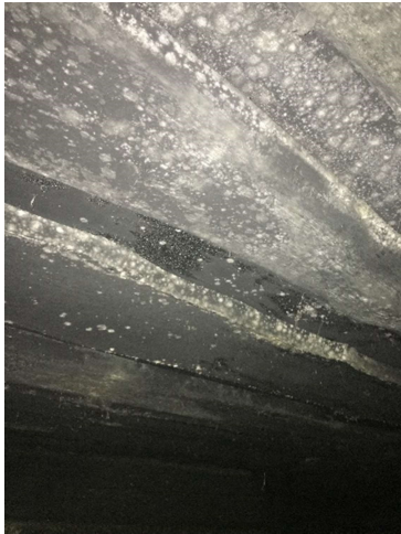
Joonis 3 Hallitusega kaetud vahelagi
