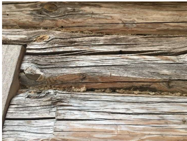
Joonis 4 Tihendusmaterjaliks olev sammal palgiridade vahel
