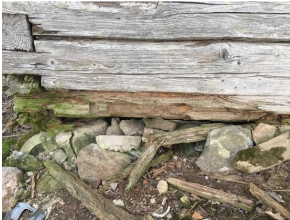
Joonis 2 Lagunenud sokkel, mädanenud alumine palgirida
