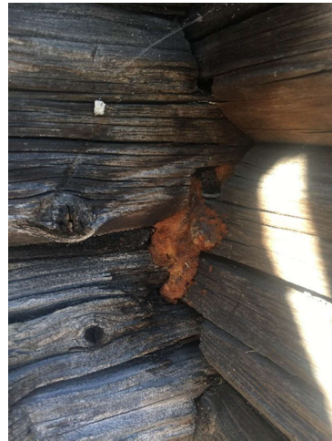
Joonis 3 Montaaživahu kasutamine
