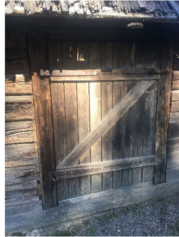
Joonis 7 Säilinud tenderpostid ja uus ukseleht
