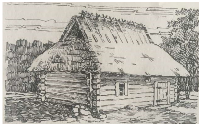
Joonis 4 Kelpkatvus õlgkattega (Tihase, 1974)
