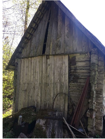
Joonis 2 Idapoolne sein; tõrvapapi jäägid seinas
