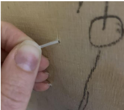
Pilt 2.1-8 Kiudoptika kiu paigaldamine valguspaneeli
