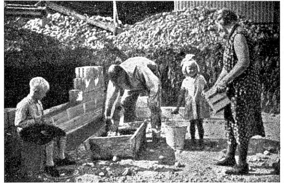
Joon. 3. Egnahems Byrå juhatusel ehitatav tööliselamu Stokholmis. Omanik koos perega töötab ise kaasa. Käsil on alusmüüride ladumine betoon-õoneskividest.
