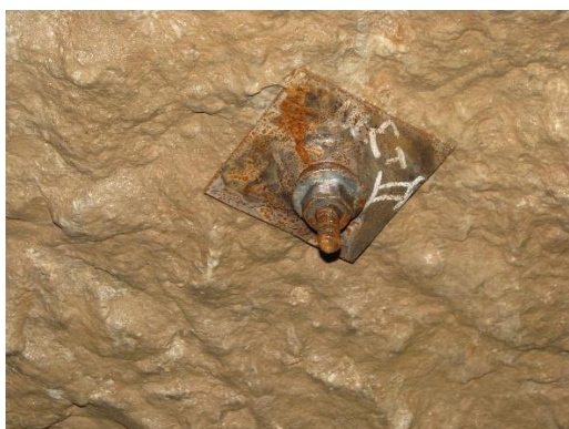
Joonis 4 Paigaldatud ankur
