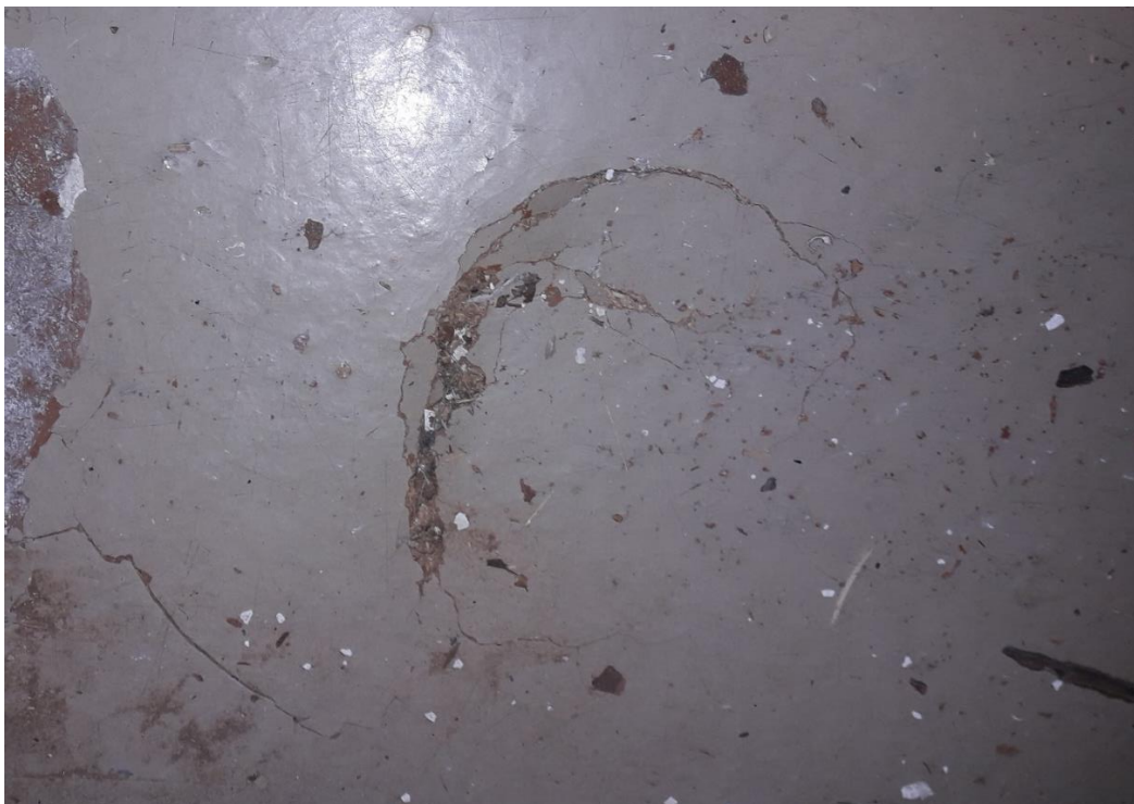
Joonis 2.11 Vajunud põrand elamu lõunapoolses osas (autori foto, märts 2021)
