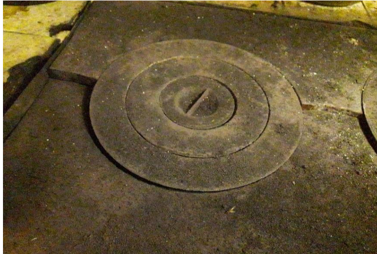
Joonis 2.37 Ära vajunud ning purunenud pliidiraud (autori foto, märts 2021)
