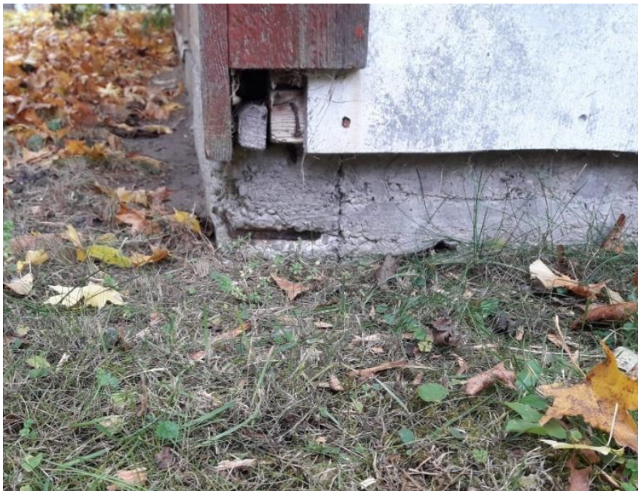
Joonis 2.9 Idapoolse pikenduse sokliosa nähtav armatuur (autori foto, märts 2021)
