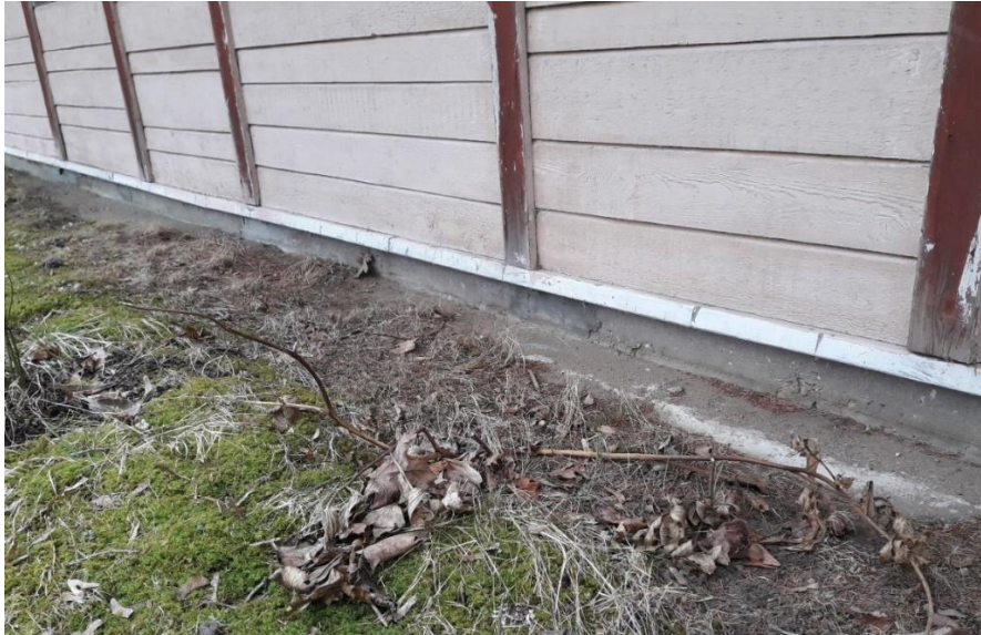
Joonis 2.8 Maakividest vundamendi sokliosale valatud betoonist vöö/särk (autori foto, märts 2021)
