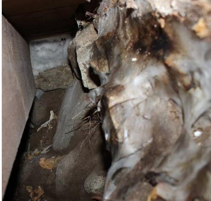
Joonis 2.38 Seeneniidistik (autori foto, oktoober 2016)
