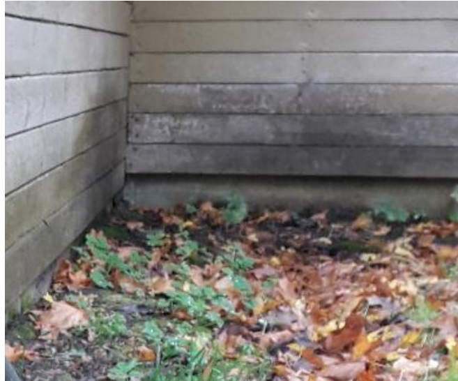
Joonis 2.10 Sokli kõrguse erinevused laudise paigalduse tõttu (autori foto, märts 2021)
