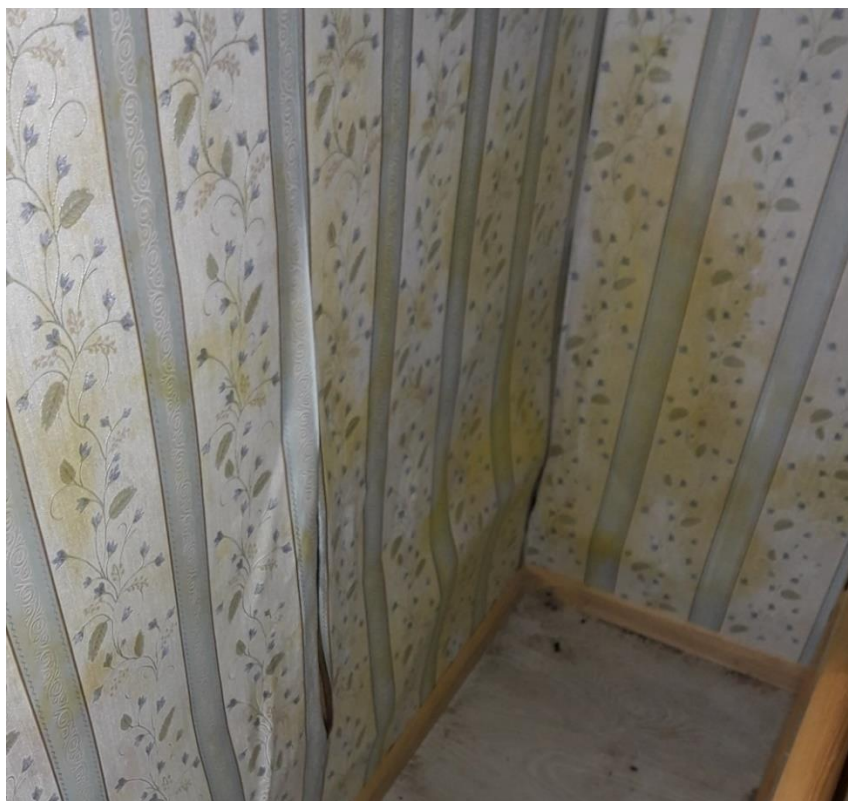
Joonis 2.17 Seenkahjustused tapeedil (autori foto, oktoober 2020)
