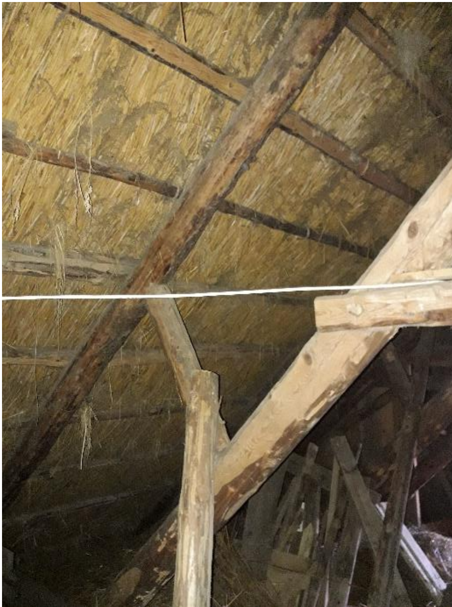
Joonis 2.21 Lõunapoolses osas laienduse sarikas toetumas esialgsele sarikale (autori foto, märts 2021)
