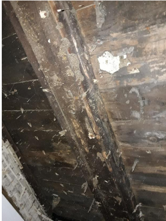
Joonis 2.20 Hoone lõunapoolse osa esimese ning katusekorruse vaheline vahelagi (autori foto, märts 2021)
