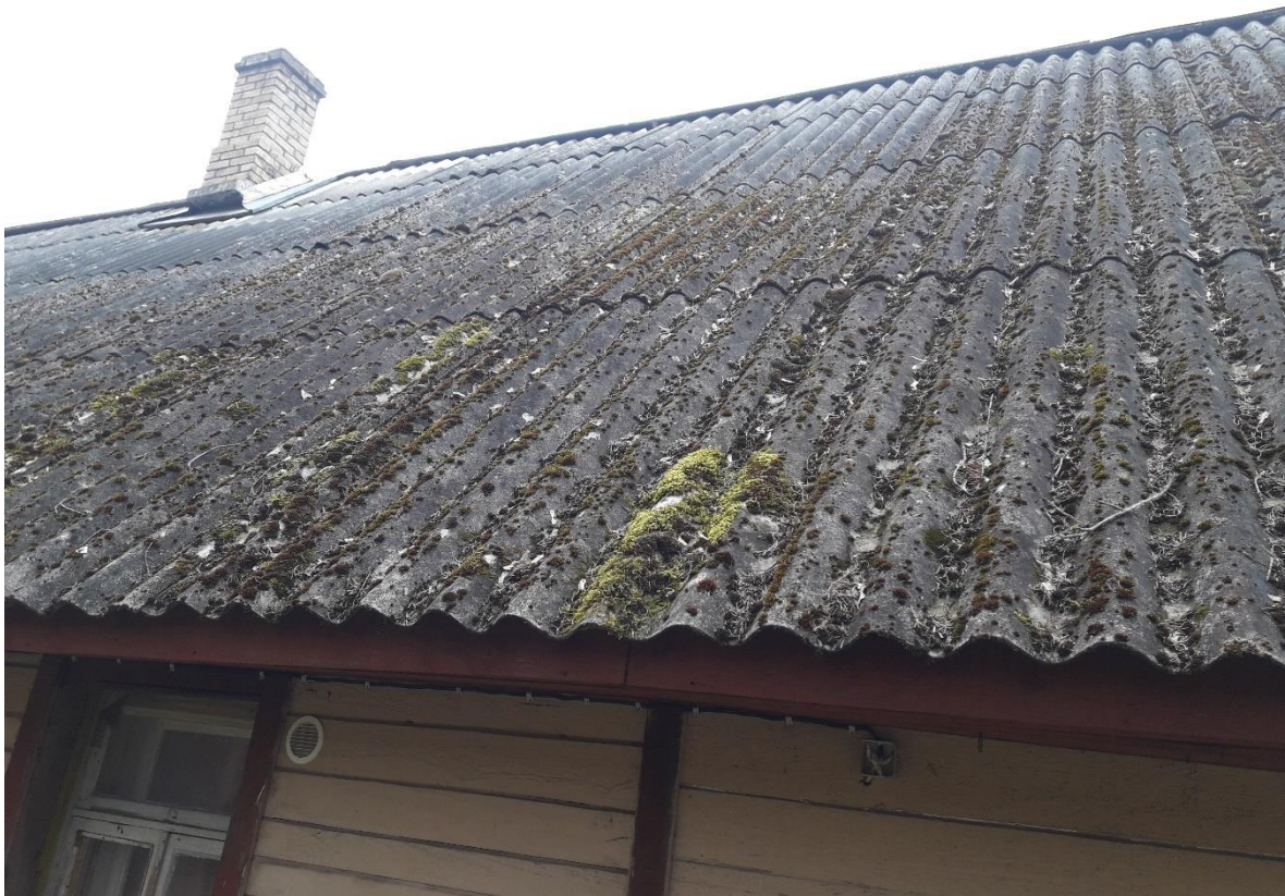
Joonis 2.23 Eterniitkatust kattev samblakiht (autori foto, märts 2021)
