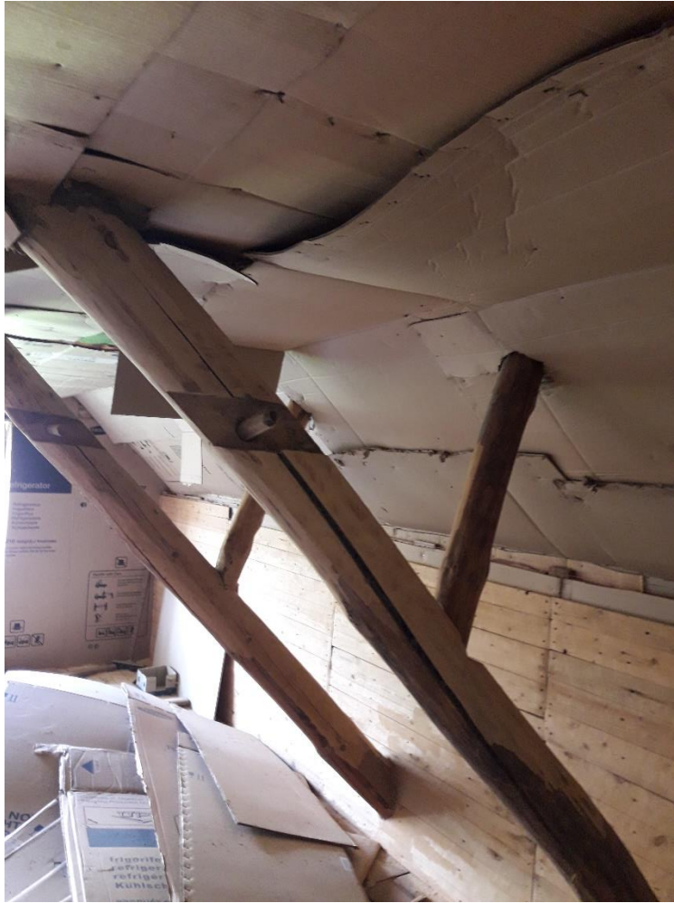
Joonis 2.24 Lõunapoolse osa papiga kaetud lagi ning katuslagi (autori foto, märts 2021)
