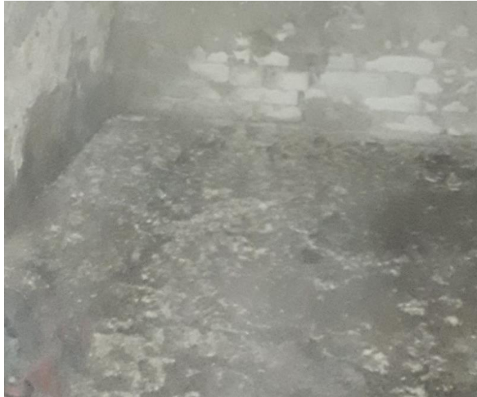
Joonis 2.12 Paekividest keldri põrand (autori foto, märts 2021)
