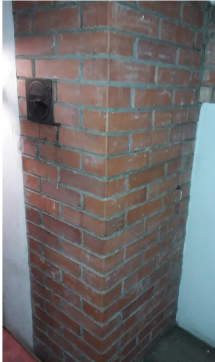
Joonis 2.33 Korstnajaala punastest tellistest osa (autori foto, märts 2021)
