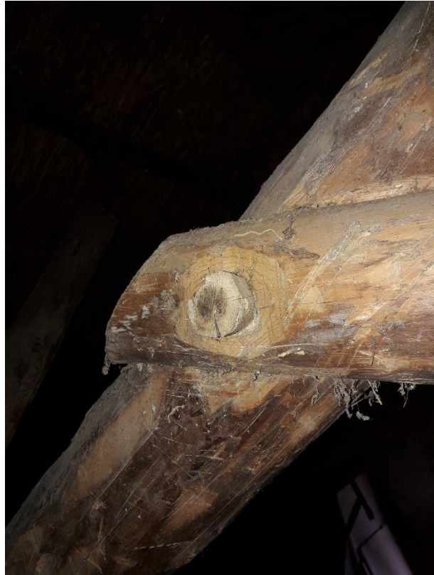
Joonis 2.22 Hoone lõunapoolses osas tapp-punnliide (autori foto, märts 2021)
