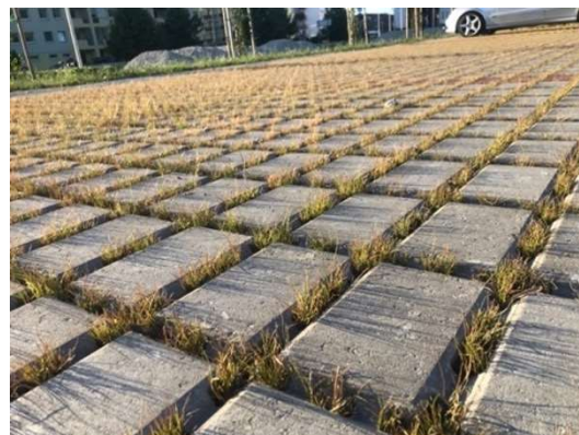
Joonis 1.6. Sillutiskivi graniitsõelmetega katend (vasakul) ning sillutiskivi murukülviga katend (paremal)
