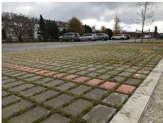
Joonis 3.5. Murukivi katendi vahede täitmine mullaga (vasakul), lõpptulemus peale aastast kasutamist (paremal)
