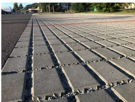
Joonis 1.6. Sillutiskivi graniitsõelmetega katend (vasakul) ning sillutiskivi murukülviga katend (paremal)
