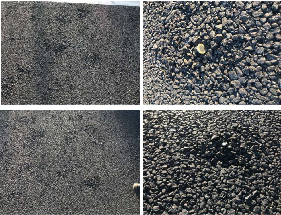
Joonis 4.11. dreenasfalt kate üks aasta peale kasutust
