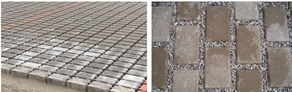
Joonis 3.6. Killustikusõelmetega täidetud sillutiskivi katend ehituskäigus (vasakul) ja peale valmimist (paremal)
