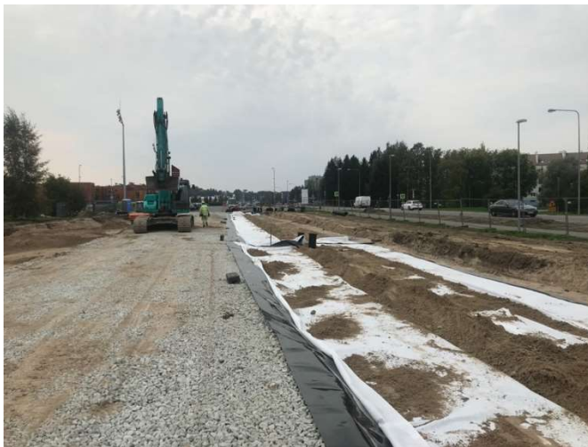
Joonis 3.4. Testaladele paigaldatud geomembraan EPDM
