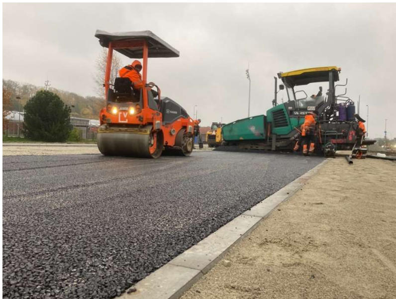
Joonis 3.2. Drenasfalti paigaldamine
