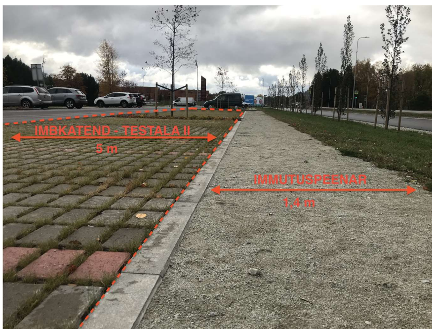
Joonis 3.8. Immutuspeenar üks aasta peale kasutamist
