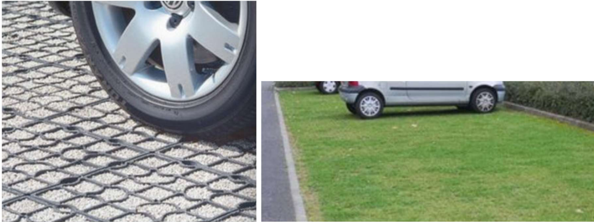
Joonis 1.9. Vasakul plastkärgraniitsõelmetega. Paremal plastkärgrurukülviga. [18]
