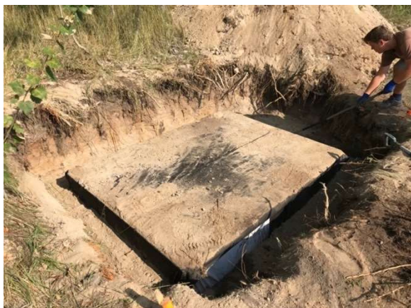
Joonis 3.9. Immutusplokkidest laotud imbpitsi ehitamine
