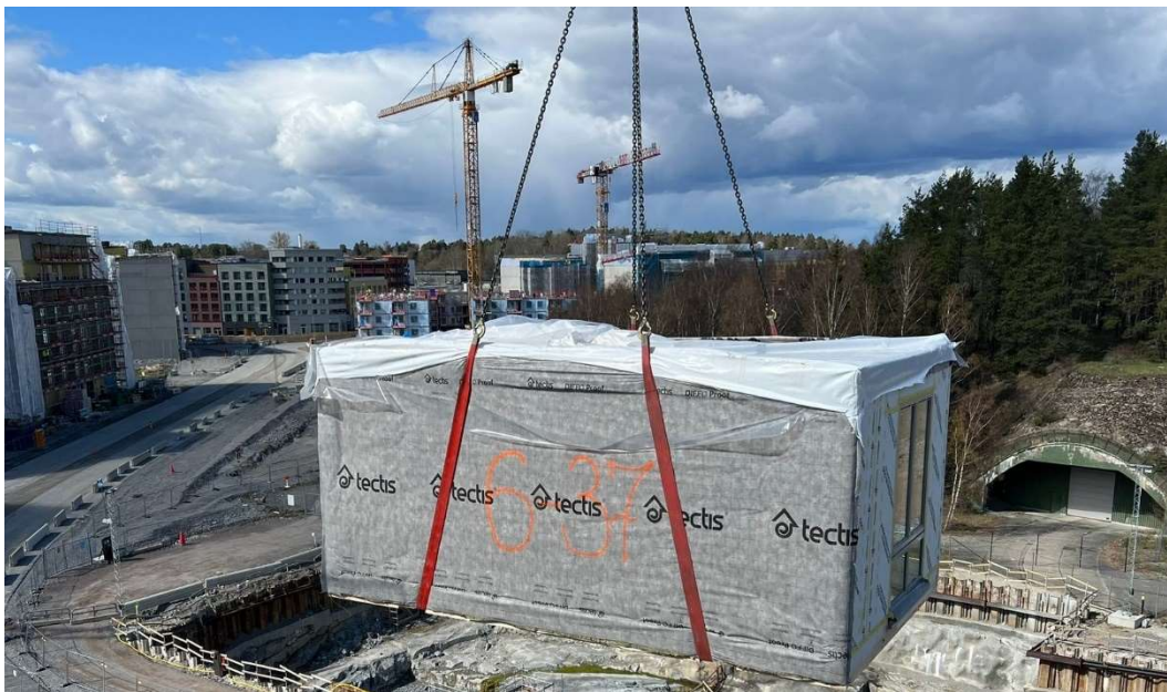
Joonis 2.7 Mooduli tõstmine tõstetroppide ja kettidega
