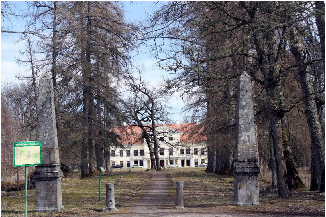
Foto nr 22. Vana-Vigala allee vaatega peahoonele
