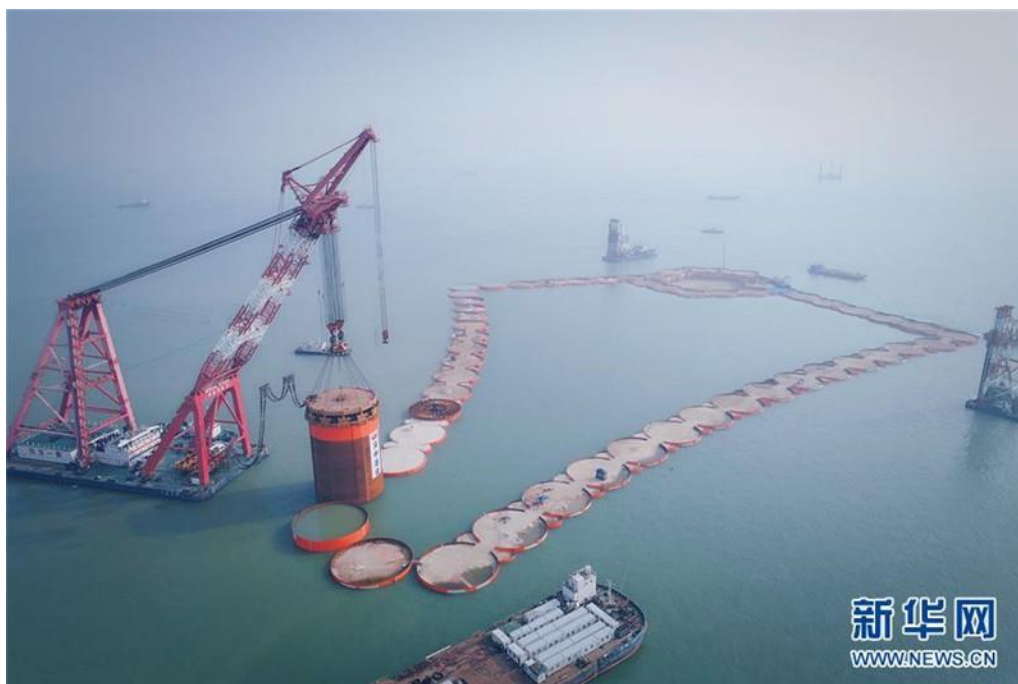
Joonis 4.4 Kessoonidest piirded Hiina tehissaarel Shenzhong sillal [15]
