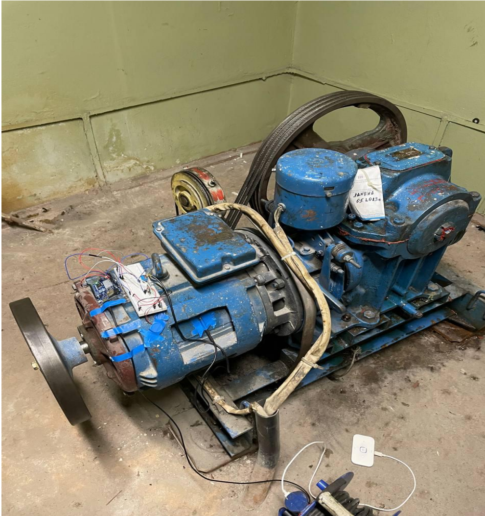
Joonis 5.4 Prototüüp lifti vintsi mootoril
