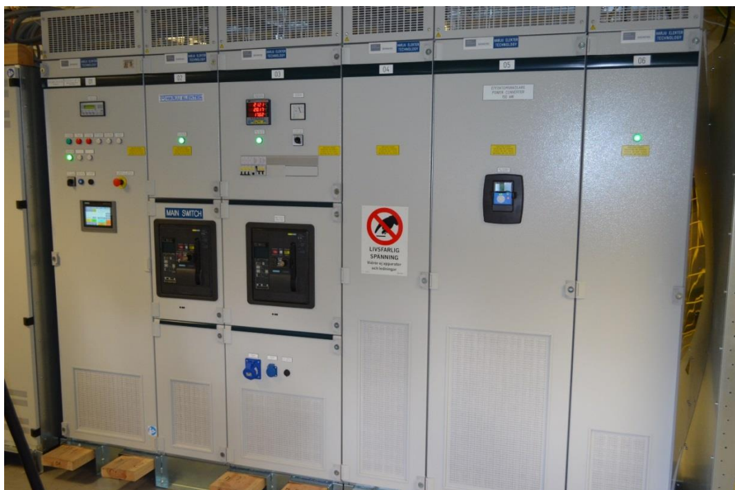
Joonis 7.3 Prototüübi muundurikilp
