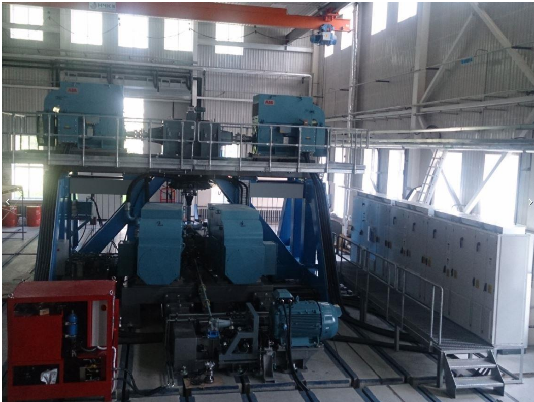
Sele 2.1 MGB katsestend [4]. Vasakul all nurgas on näha hüdrojaama konstruktsioon (punane). Konstruktsiooni puuduseks võib pidada seinade puudumist (müra levik). Konstruktsioon on väga kompaktne, kuid see võib raskendada ligipääsu vahetamisel vajavatele komponentidele.
