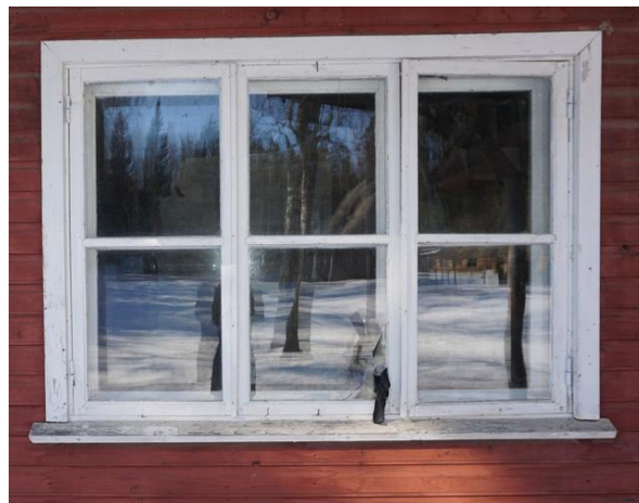
Joonis 3.74 Vaade kaheraamsele aknale (Foto: autor, märts 2022)
