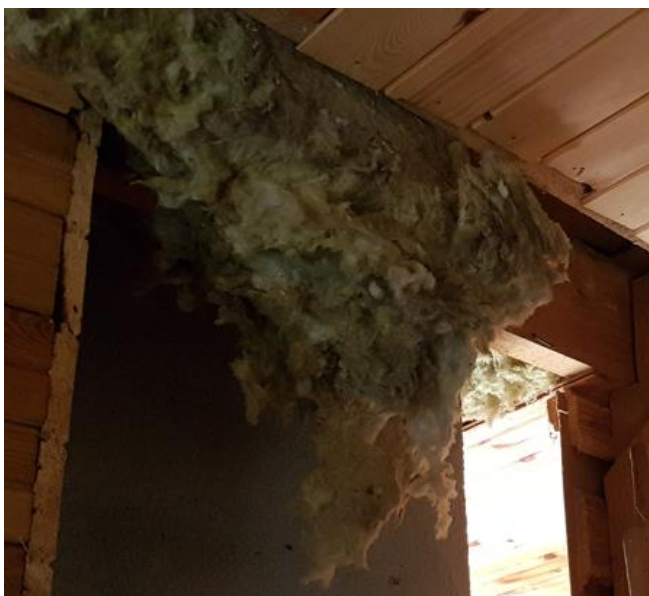
Joonis 3.57 Vaade korstna ümbruses viimistlemata laele ning korstna ümbruses kasutatud alla vajunud villale (Foto: autor, märts 2022)
