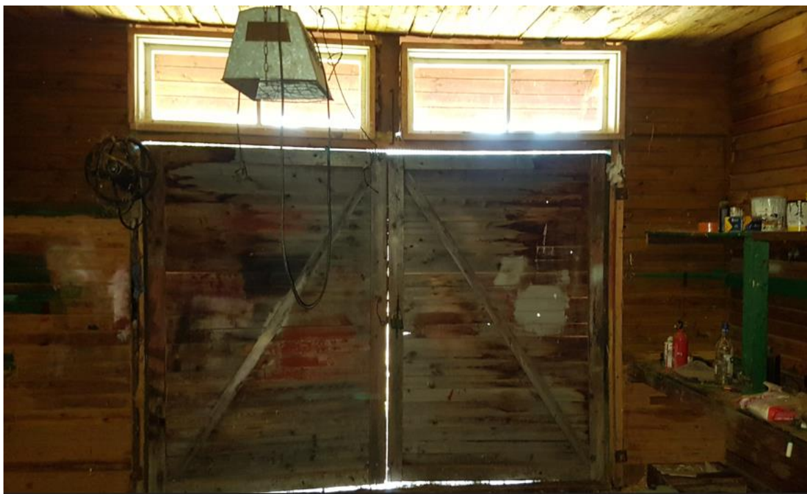
Joonis 3.52 Vaade garaažiuksele seestpoolt (Foto: autor, märts 2022)
