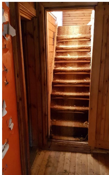
Joonis 3.41 Vaade teise korruse trepile (Foto: autor, märts 2022)
