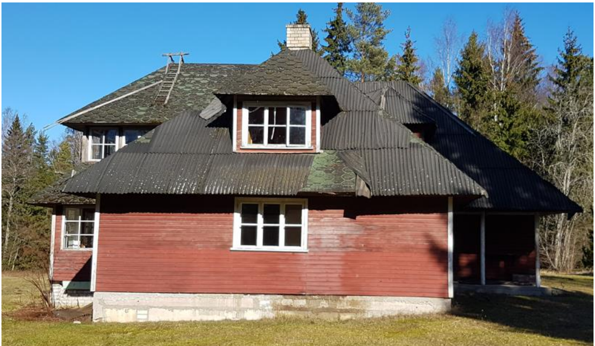
Joonis 1.5 Vaade hoonele kagust (Foto: autor, mai 2022)
