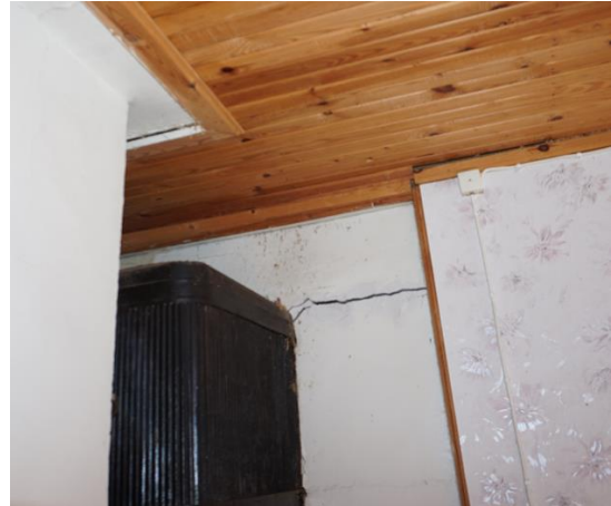
Joonis 3.45 Vaade samast praost teiselt poolt seina (Foto: autor, märts 2022)
