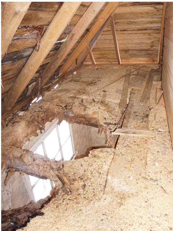
Joonis 3.67 Vaade sisse varisenud pööninglaele (Foto: autor, märts 2022)
