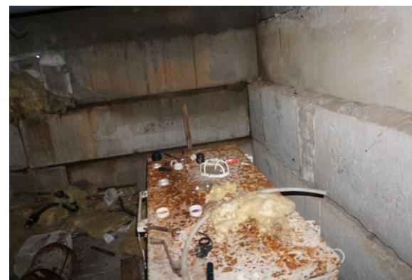
Joonis 3.31 Vaade niiskuskahjustustega keldriseinale (Foto: autor, märts 2022)
