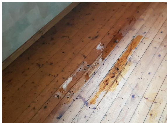
Joonis 3.38 Vaade seenkahjustustega põrandale (Foto: autor, märts 2022)
