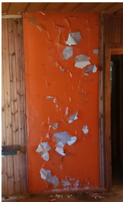
Joonis 3.42 Vaade ühele korstnale esimeselt korruselt (Foto: autor, märts 2022)
