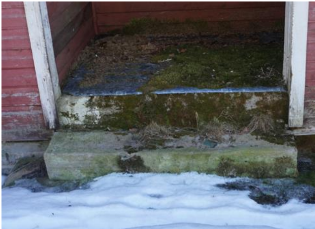
Joonis 3.22 Kirdeküljel paikneva sissepääsu betoonist trepp mademega (Foto: autor, veebruar 2022)
