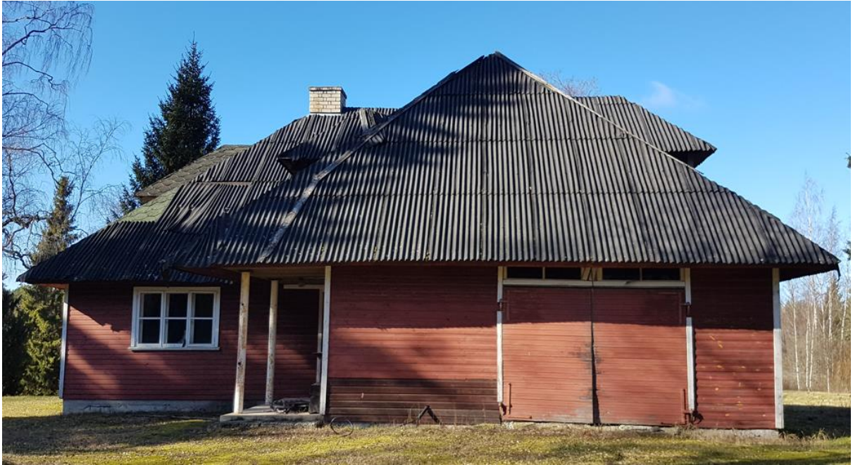
Joonis 1.2 Vaade hoonele kirdest (Foto: autor, mai 2022)
