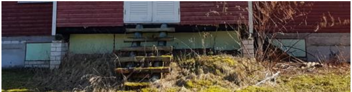
Joonis 3.2 Silikaattellistest ning osaliselt isoleeritud sokkel hoone loodeküljel (Foto: autor, aprill 2022)
