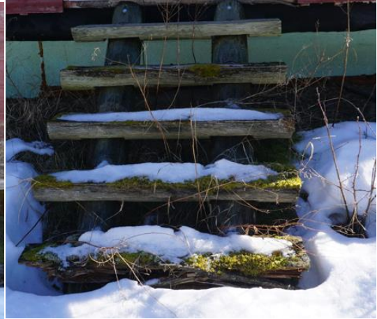
Joonis 3.21 Loodeküljel paikneva sissepääsu poolpalkidest trepp (Foto: autor, veebruar 2022)
