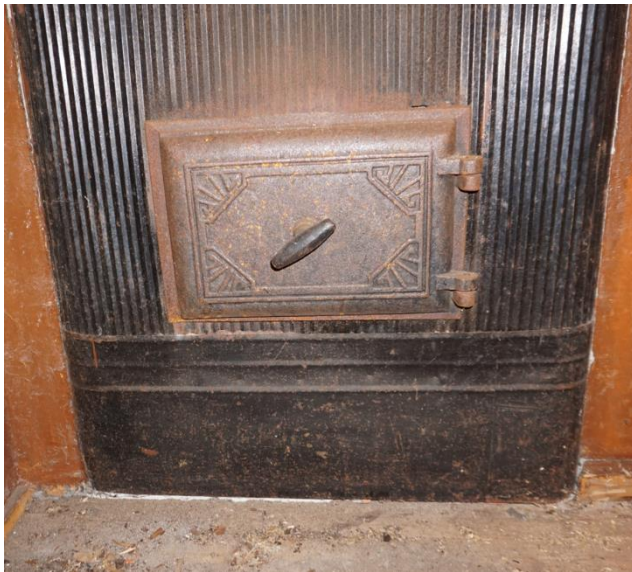
Joonis 3.23 Esimesel korrusel paiknev plekk-kattega ahi (Foto: autor, veebruar 2022)
