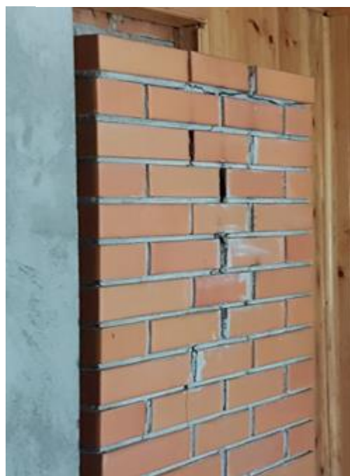
Joonis 3.60 Vaade pragunenud tellisahjule (Foto: autor, märts 2022)
