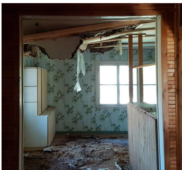
Joonis 3.36 Vaade sisse kukkunud vahelaale köögis (Foto: autor, märts 2022)
