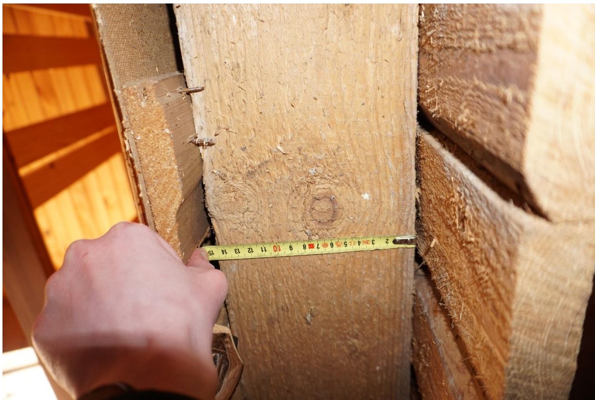
Joonis 3.5 Vaade siseseina konstruktsioonile (Foto: autor, veebruar 2022)
