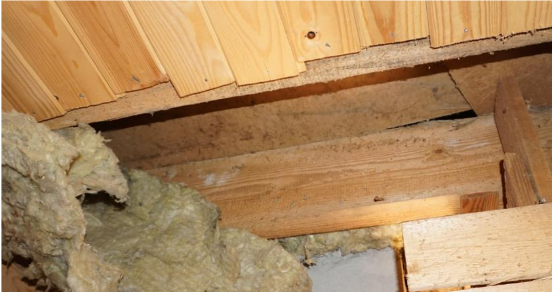
Joonis 3.11 Teise korruse pooleldi viimistletud lagi koos väljavajunud villaga. Nähtaval laelaudis, talad ning saepuruplaat (Foto: autor, veebruar 2022)
