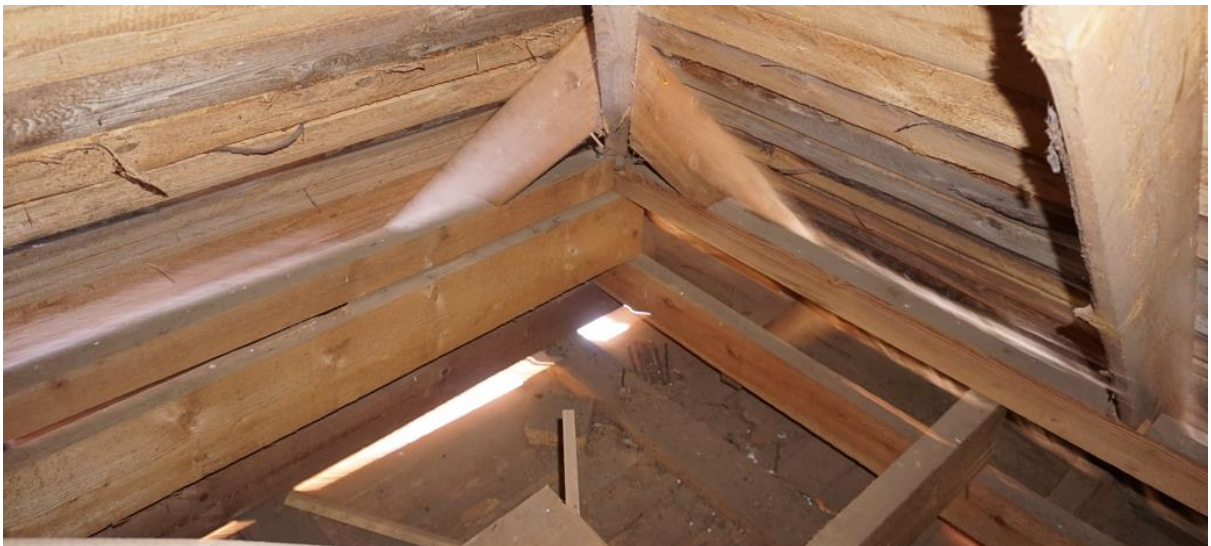
Joonis 3.10 Vahelae konstruktsioon pööningult vaadatuna (Foto: autor, veebruar 2022)
