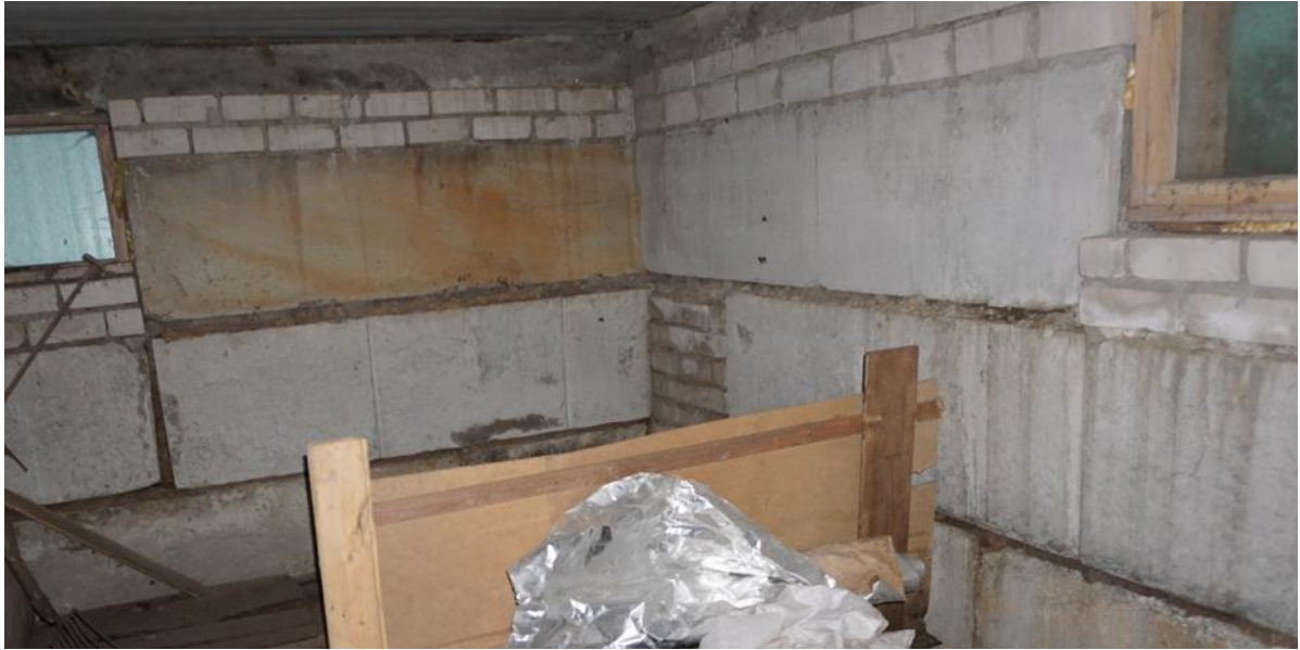
Joonis 3.1 Tellistest ja plokkidest vundamendisein (Foto: autor, veebruar 2022)
