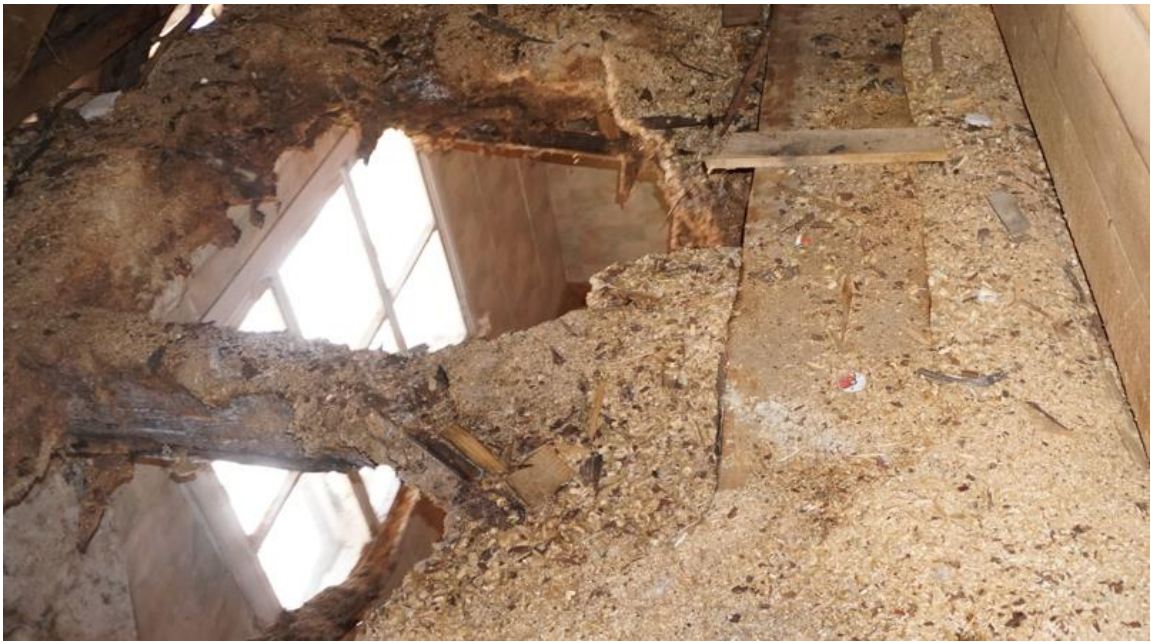
Joonis 3.13 Osaliselt sisse kukkunud vahelagi ühes toas (Foto: autor, veebruar 2022)
