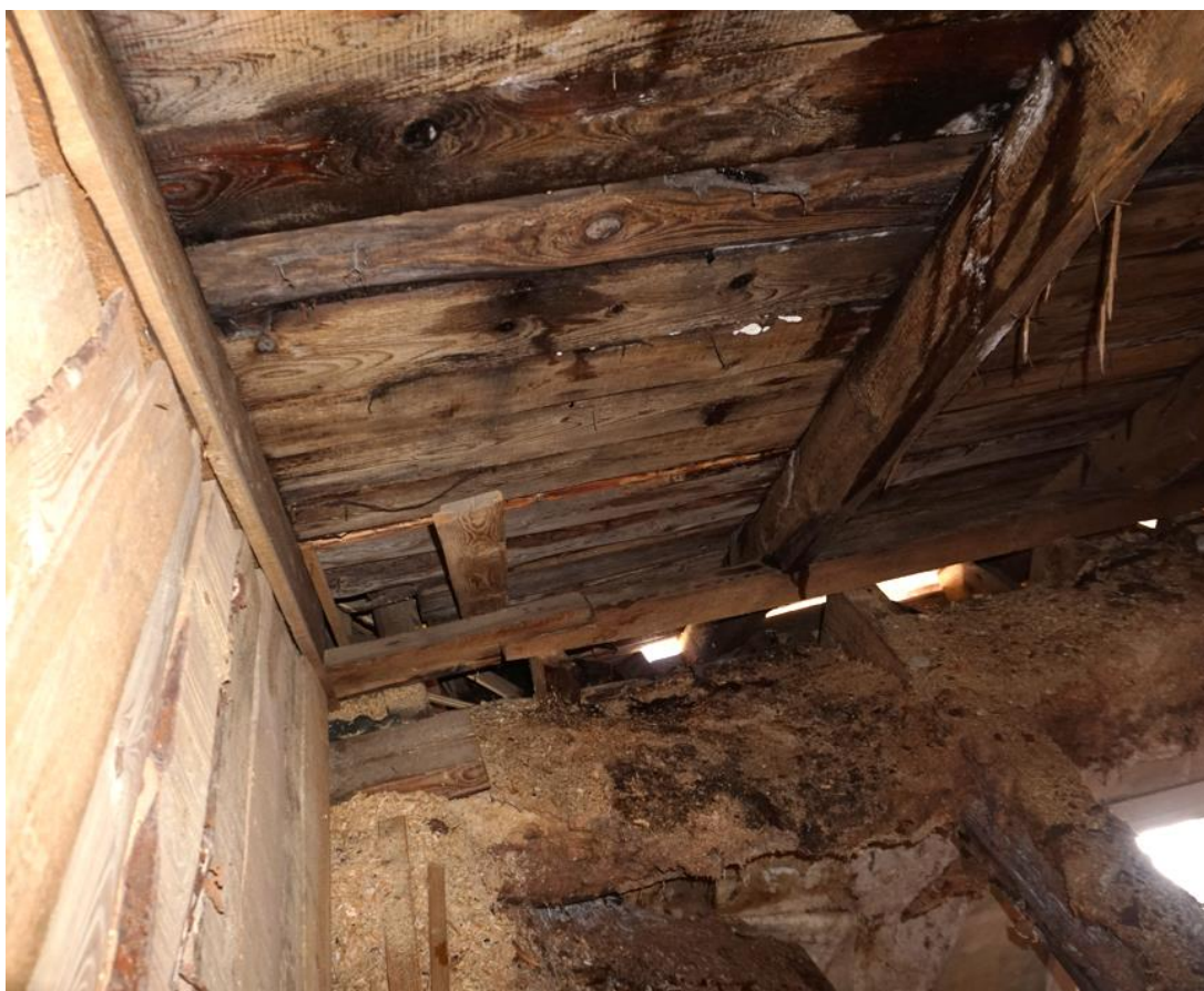
Joonis 3.8 Vaade roovitisele ja sarikatele sissevarisenud vahelaega pööninguosas, vasakule jääb soojustatud sisesein (Foto: autor, veebruar 2022)
