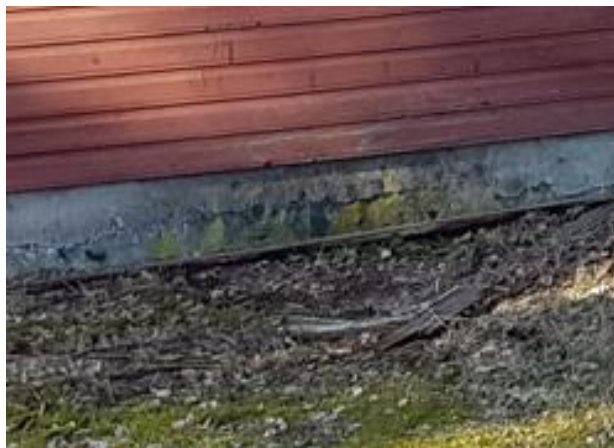
Joonis 3.3 Niiskuskahjustused soklis (Foto: autor, aprill 2022)
