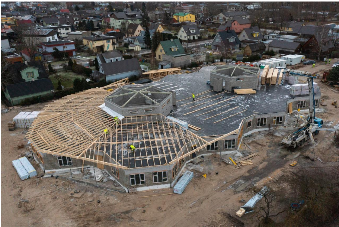
Joonis 6.3 Katuse puitfermide paigaldus
