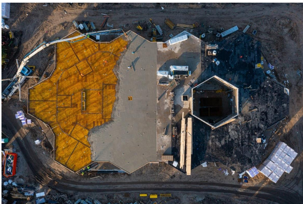
Joonis 6.2 Monoliitsest raudbetoonist vahelae betoneerimine
