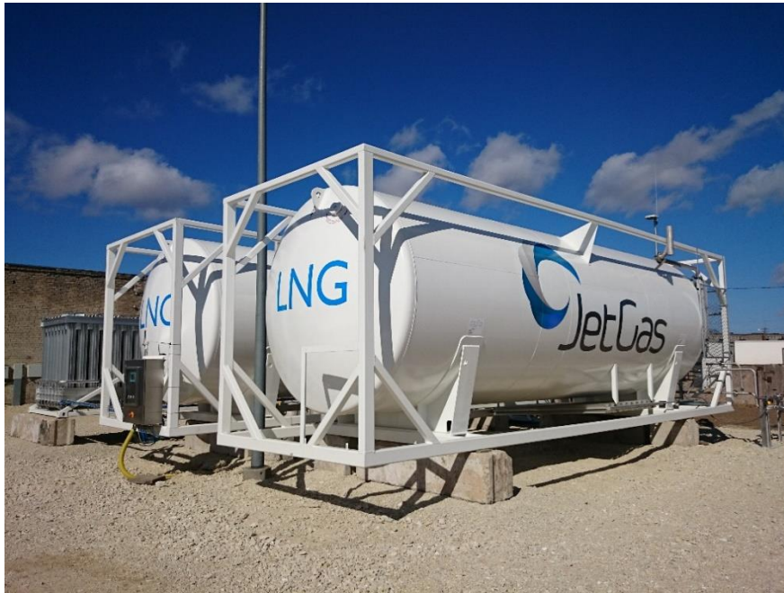
Joonis 1.4 – Paines olev gasifitseerimisjaam horisontaalsete mahutitega [23]
