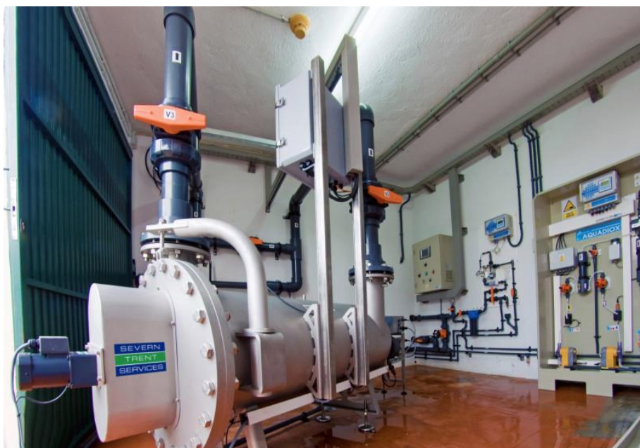
Рисунок 8. Комбинированная обработка воды ультрафиолетовым излучением и диоксидом хлора [65]
