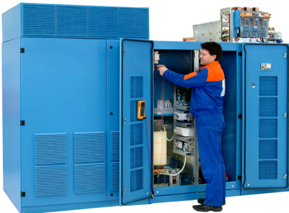
Joonis 1.14. Veoalajaama statsionaarne energiasalvesti [HOC07]
