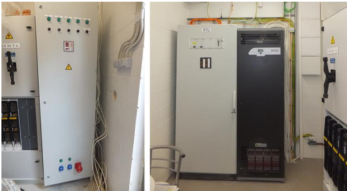
Joonis 7.12. Alalisvoolu keskus ja vahelduvvoolu keskus koos RTU kapiga
