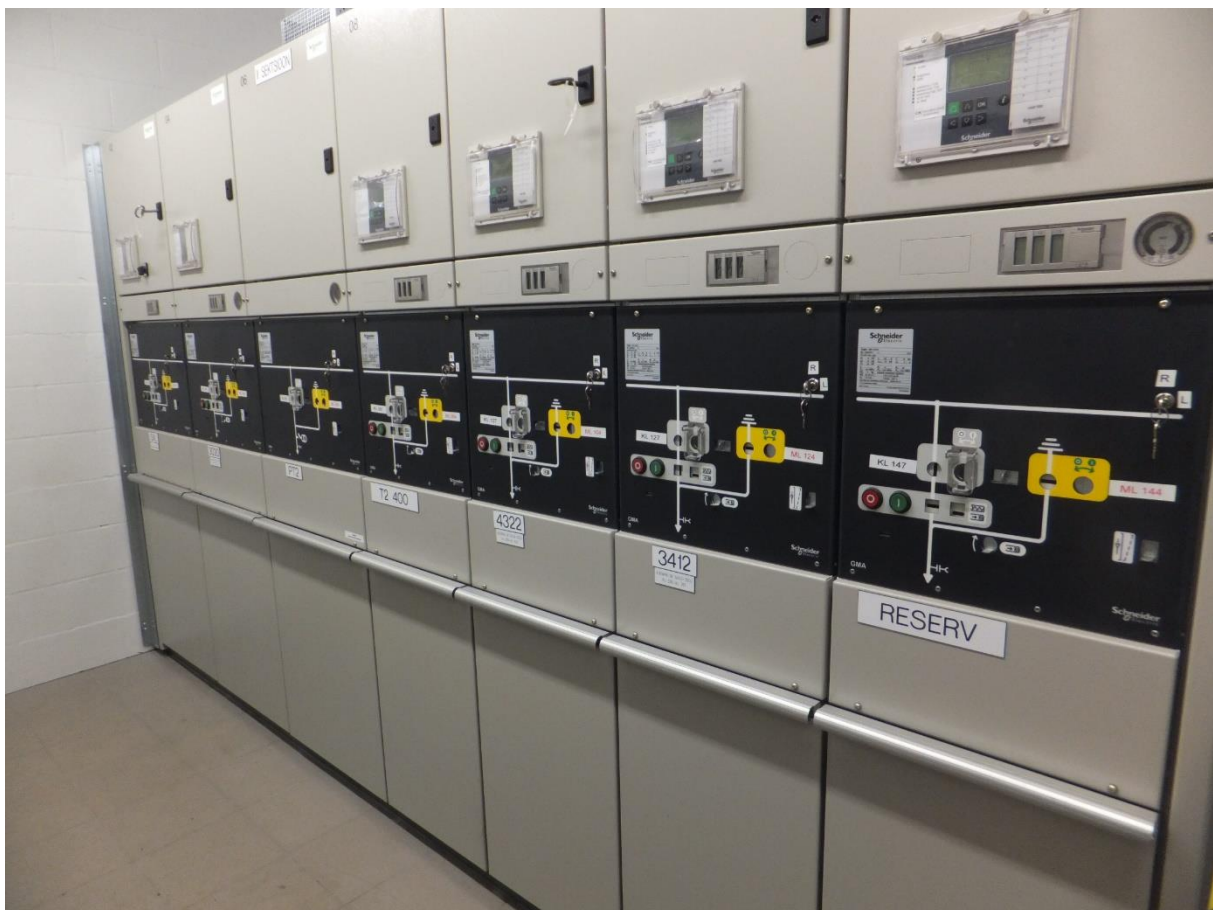
Joonis 8.10. 6 kV jaotuseadme II sektsiooni tähistused
