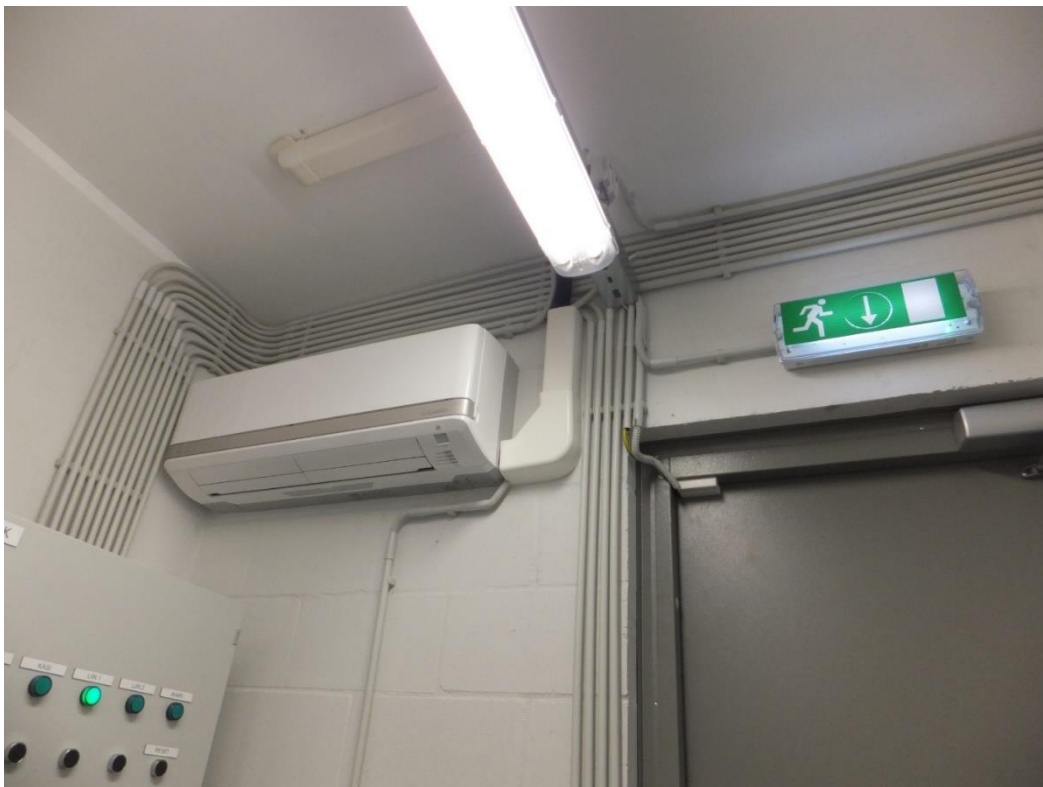
Joonis 7.14. Evakuatsioonivalgustuse paigaldus madalpingeseadmete ruumis
