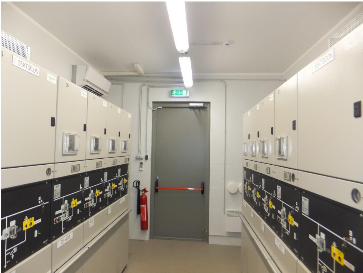
Joonis 7.13. Luminofoorlampvalgustite paigaldus keskpingseseadmete ruumis
