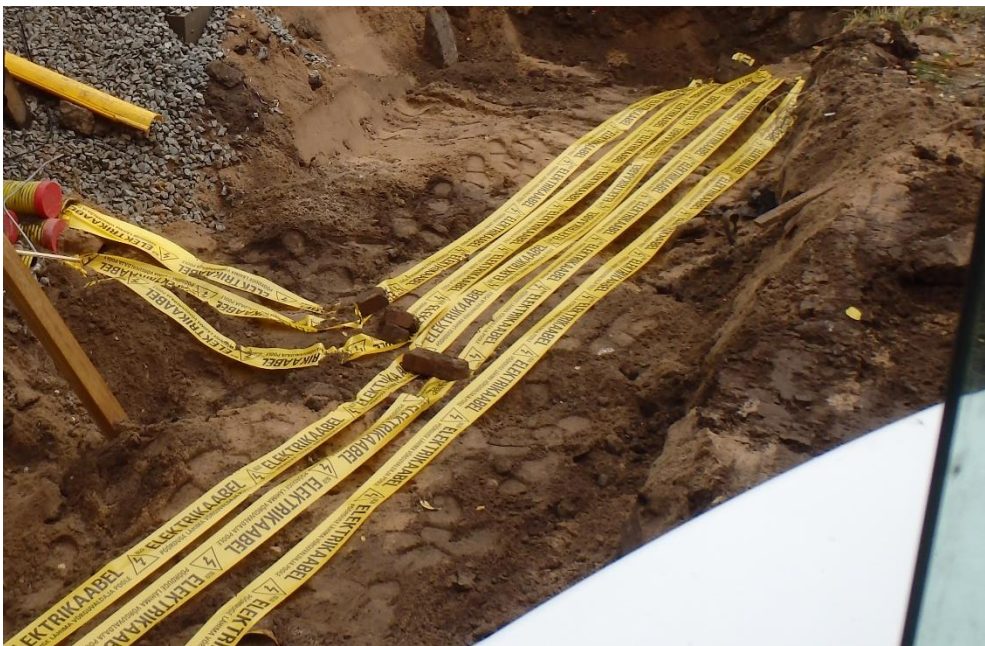
Joonis 7.10. Kaabelliinide ohutuslint
