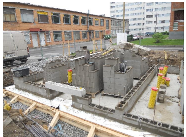
Joonis 7.2. Alajaama hoone vundament
