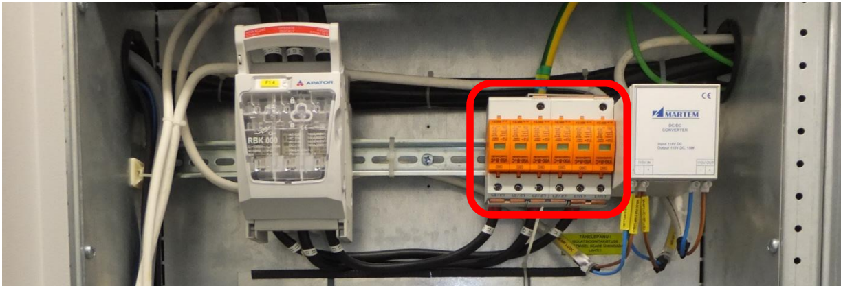
Joonis 7.19. Liigpingepiirikute paigaldus 0,4kV jaotusseadmetes
