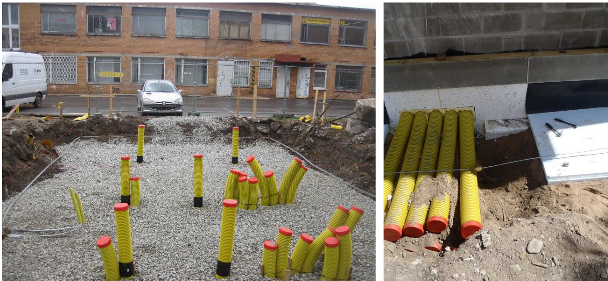
Joonis 7.11. Alajaama maanduspaigaldis
