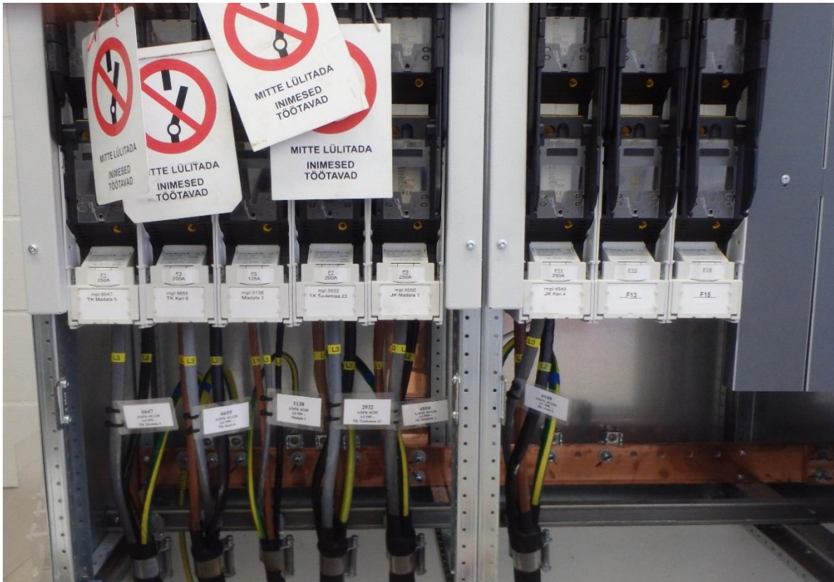
Joonis 8.2. Madalpinge (0,4 kV) jaotla
