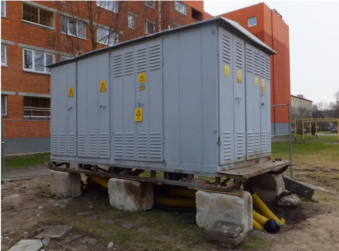
Joonis 6.2. Ajutine alajaam 590A
