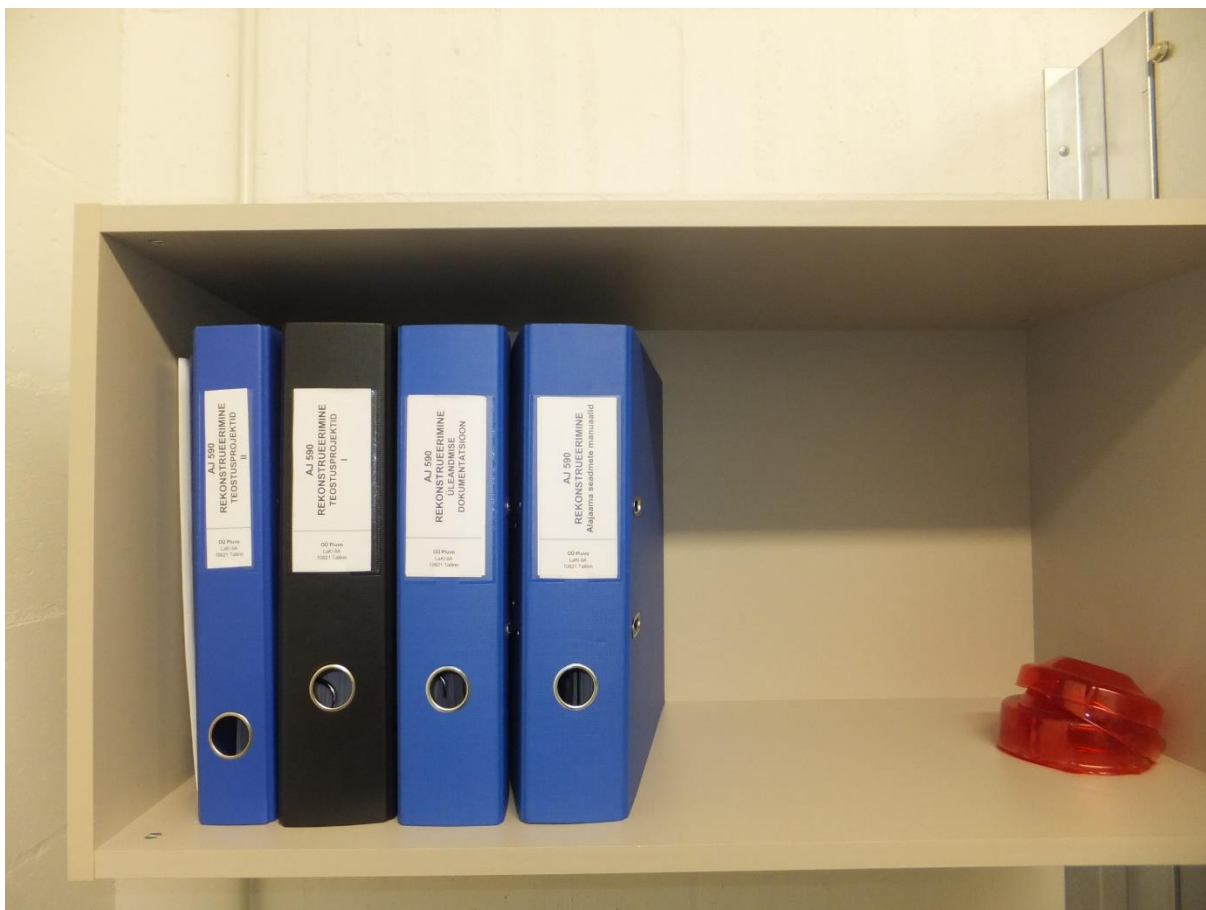
Joonis 8.12. Jaotusalajaama dokumentatsioon 6 kV jaotusseadme ruumides
