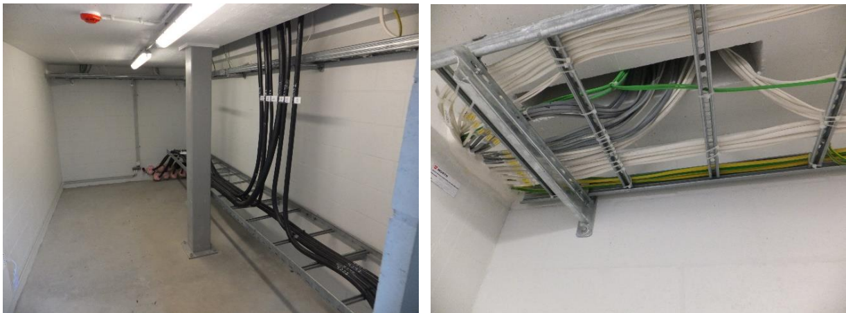
Joonis 8.4. Kaabelliinide ja juhtide paigaldusviisid
