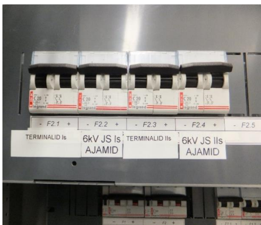
Joonis 8.6. Kahepooluselised kaitselülitid alalisvoolu keskus
