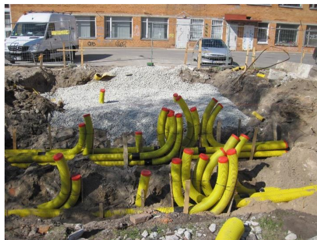
Joonis 7.9. Kaitsetorud vundamenti all
