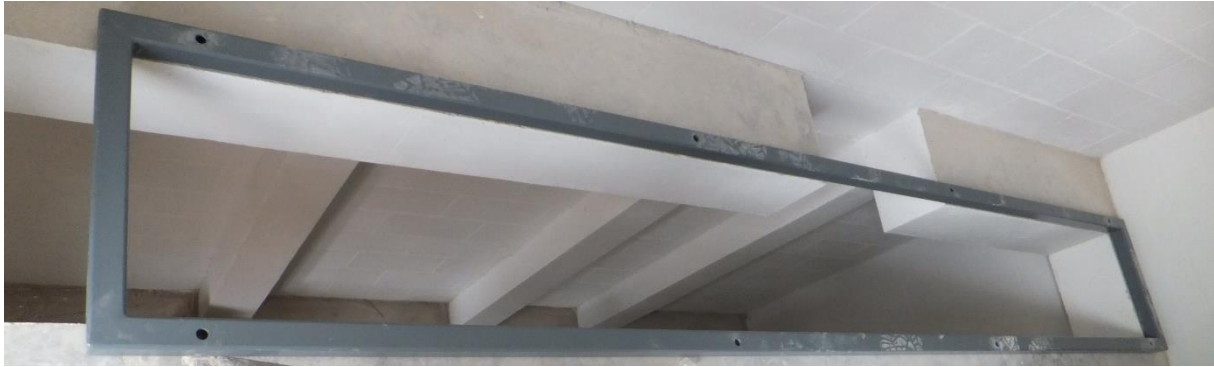
Joonis 7.7. Keskpinge jaotusseadmete alusraam
